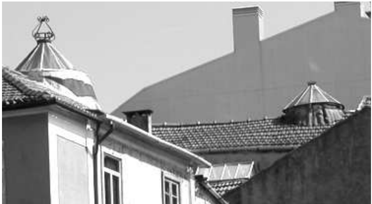
Fig.60 – Clarabóias tradicionais em telhados, Porto. Fonte - Tecnologias Solares Passivas , Cap.V, p.12.
