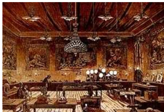
Fig.51 - Iluminação eléctrica nos espaços internos, ao final do século XIX. Fonte - Mascaró, 2005, s/p.
