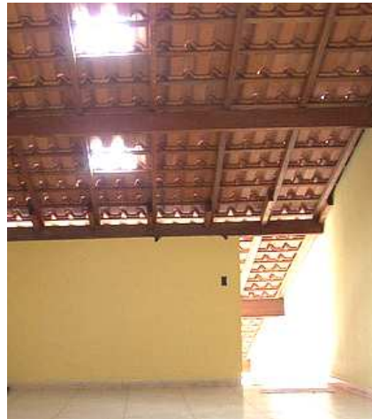
Fig.63 - Telha de vidro no telhado tradicional.
