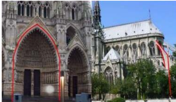
Figuras 84, 85, 86, 87: Edifícios com Arcos
