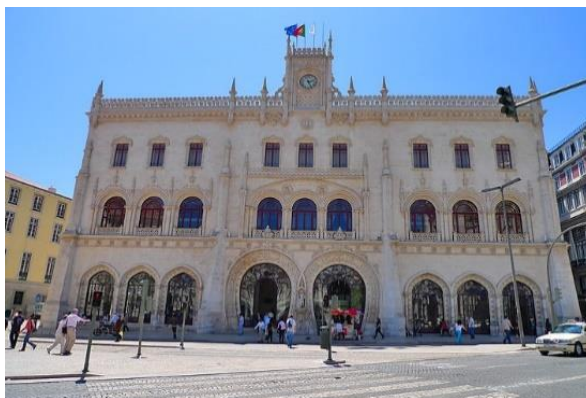
Figura 32: Estação Ferroviária do Rossio – Lisboa
