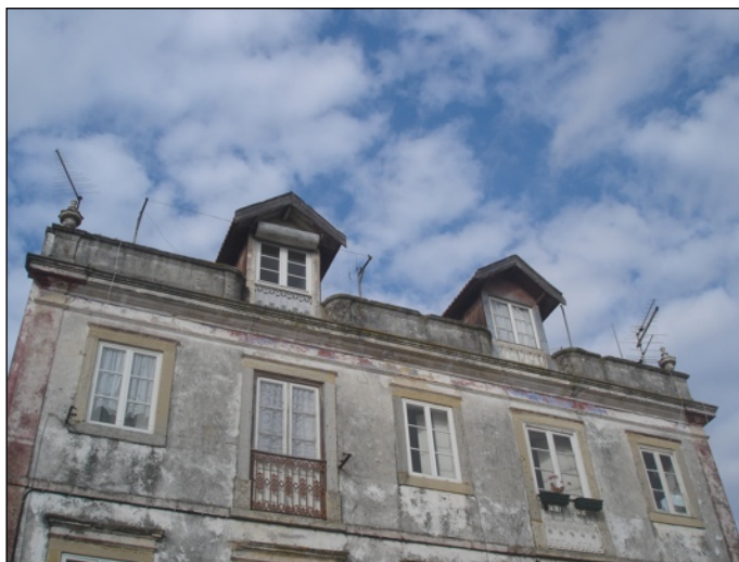
Figura 6 - Clarabóias nas construções típicas de Alcochete Fonte: o autor. 2010.
