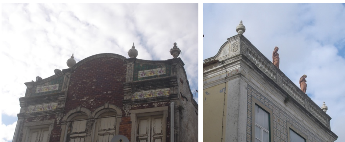
Figura 4 - Edifício do Largo de S. João. Destaque para ornamentação da platibanda com pinhões, vasos ou estátuas. Fonte: o autor - 2010.
