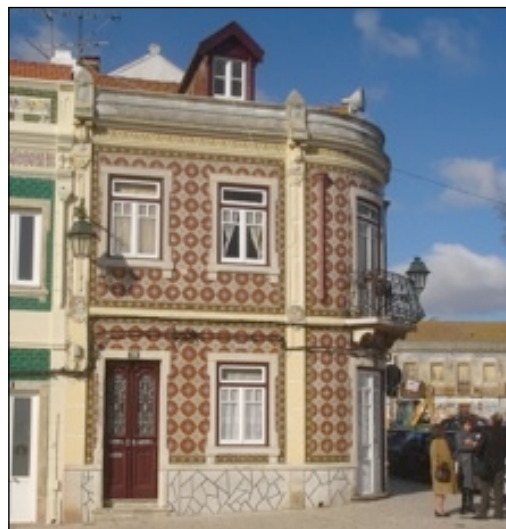
Figura 14 - Edifício do Lg. São João nº 19 e 20 Fonte: o autor. 2010.
