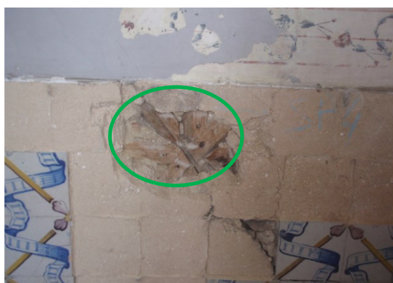
Figura 77. Parede de frontal, nó de junção de 4 cruces de Santo André
