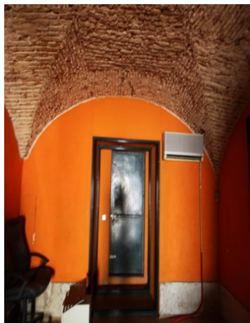
Figura 65. Espaço no piso térreo.
