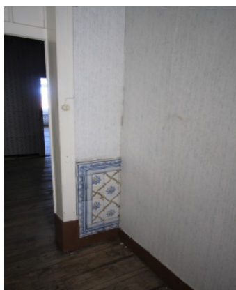
Figura 108. Terceiro andar; inserção de parece divisória sobre lambrim de azulejos pombalinos.
