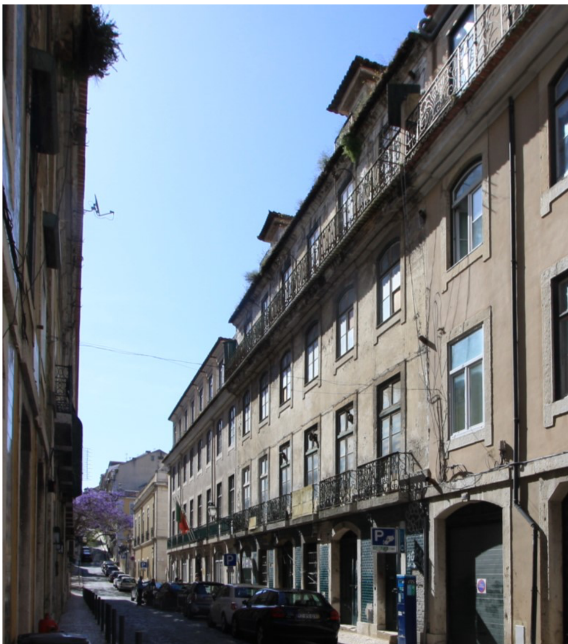
Figura 40. Edifício na Rua de São Mamede N. 25A 25C Freguesia de Santa Maria Maior (foto autor do trabalho).
