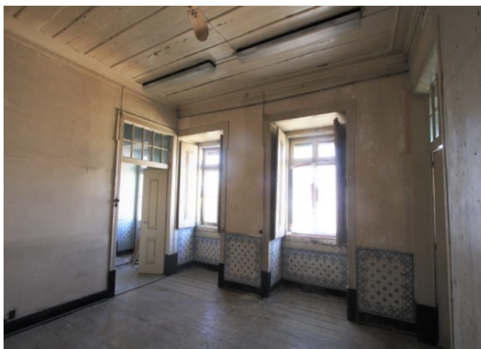
Figura 95. Segundo andar; degradação do pavimento em madeira, degradação de paredes por empolamentos e desagregações, degradação dos tetos com empolamentos de tinta, elementos em madeira degradados com empolamentos de tinta.
