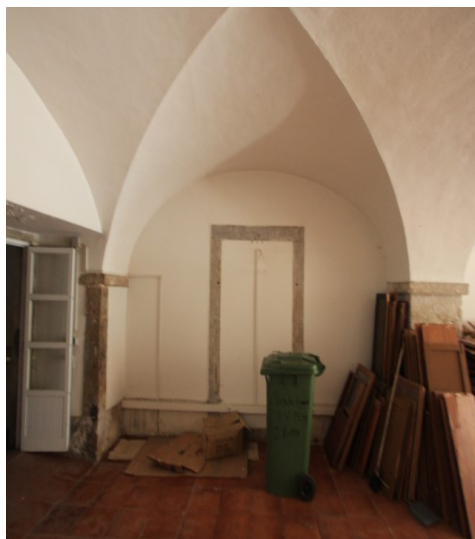
Figura 64. Espaço no piso térreo.
