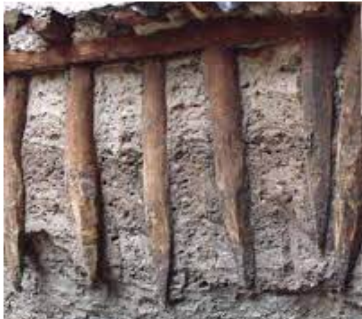
Figura 11. Estacas de madeira encontradas sob as fundações de edifícios pombalinos.
