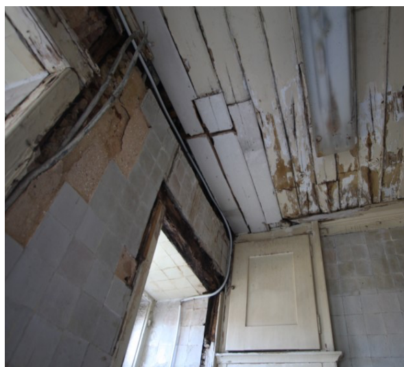
Figura 95. Segundo andar; degradação do pavimento em madeira, degradação de paredes por empolamentos e desagregações, degradação dos tetos com empolamentos de tinta, elementos em madeira degradados com empolamentos de tinta.
