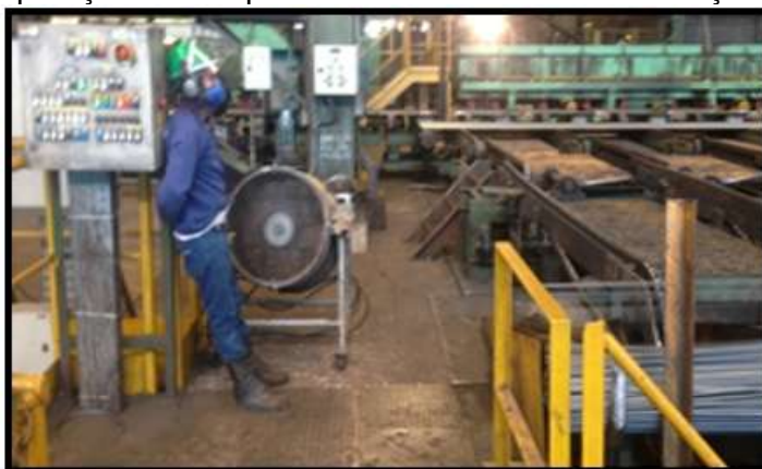
Foto 6. Painel de operação e acompanhamento das correntes e braço formador de feixes.
