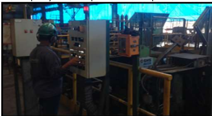
Foto 8. Painel de operação e acompanhamento do processo nas amarradeiras.
