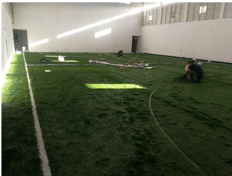
Figura 2 - Pavilhão em remodelação
