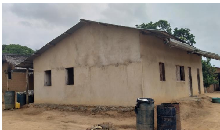
Fig.67- Sistema de recolha da água da chuva a partir da cobertura Fonte: (Imagem do autor), 2019
