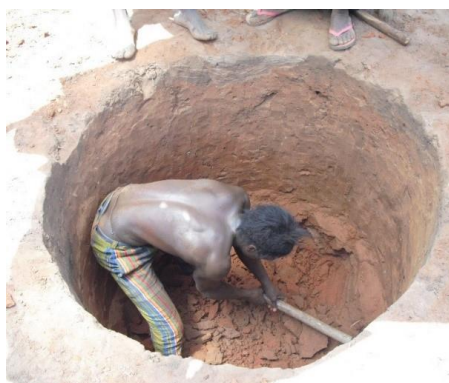
Fig.61- Processo de escavação de terra para a fabrico de adobe Fonte: (Imagem do autor), 2019
