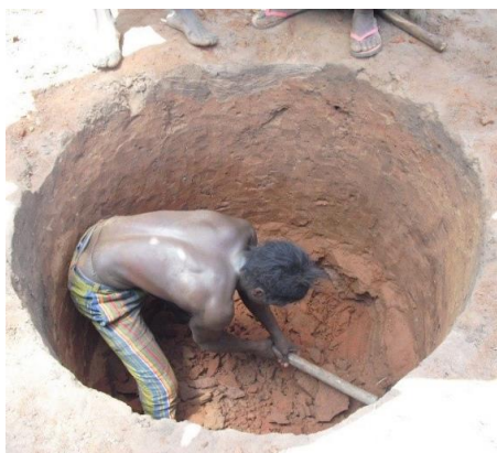
Fig.69- Processo de escavação da cova para a latrina
