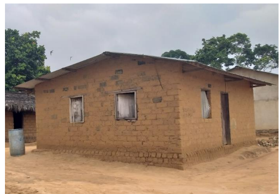
Fig.49- casa de adobe com reboco de cimento Fonte: (Imagem do autor), 2019
