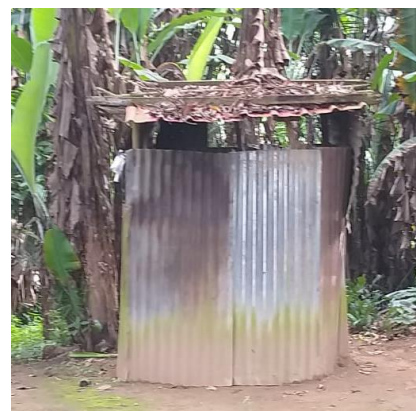
Fig.71- Casa de banho de chapa
