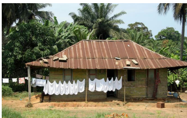
Fig.40- Casa de madeira no interior de Cabinda
