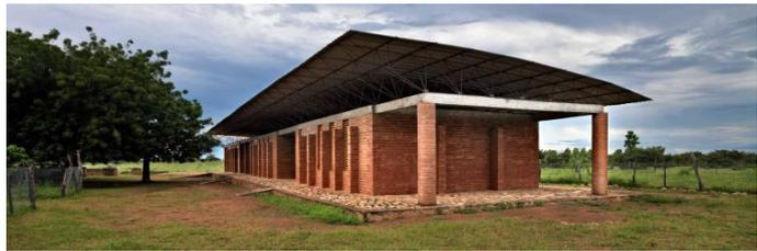
Figura 3- Fotografia evidenciando a cobertura de zinco suspensa da Escola Primária de Gando. (Kéré Arquitetura, 2014)
