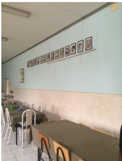
*Figura 29- Salas de aulas e aposentos do Seminário Menor Salesiano de Dom Bosco. Refeitório, paredes interiores revestidas com reboco e azulejos mostrando que é possível a utilização de vários tipos de revestimentos*
