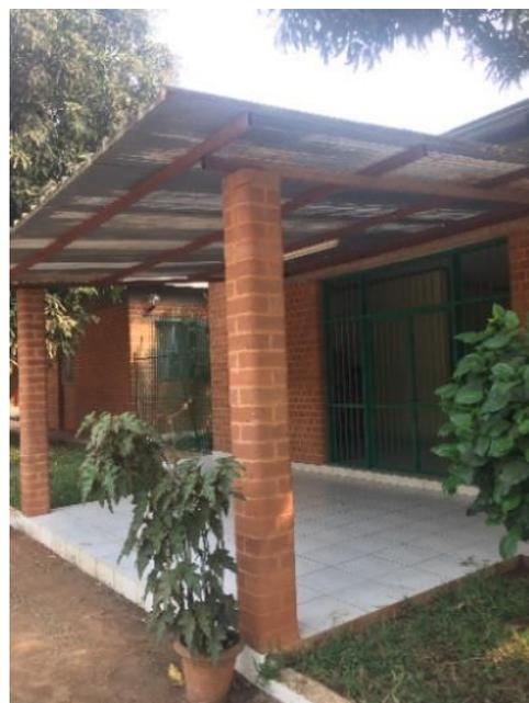
*Figura 30- Salas de aulas e aposentos do Seminário Menor Salesiano de Dom Bosco. Cobertura em chapa metálica e pilares em adobe mostrando a resistência à compressão.*
