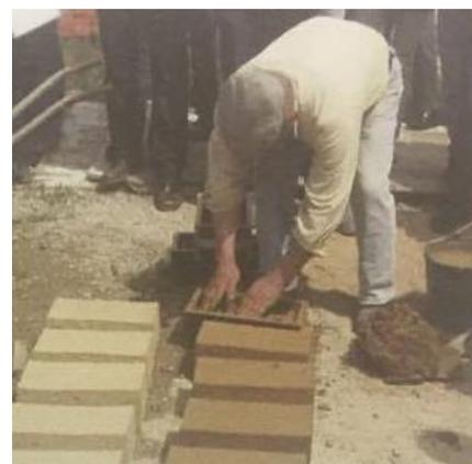
*Figura 48 – Processo de moldagem: regularização da superfície com uma régua, para se tirar o excesso de terra. (Fernandes & Tavares, 2016, p. 36)*
