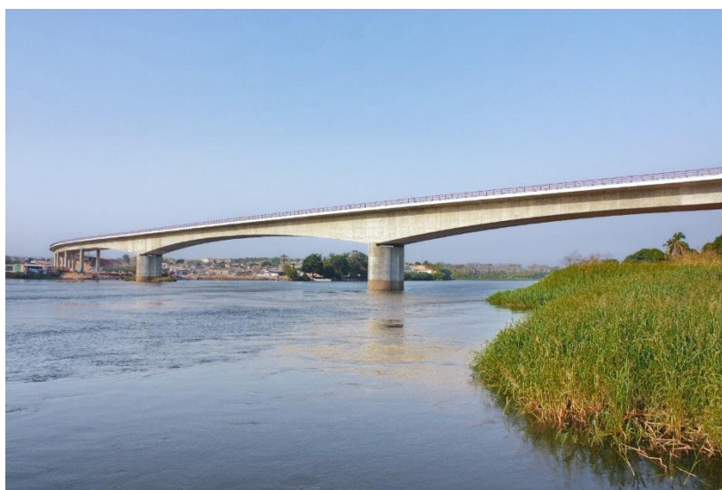
Figura 29 - Ponte 17 de Setembro sobre o rio Kwanza (Armando Rito Engenharia, S.A) ´
