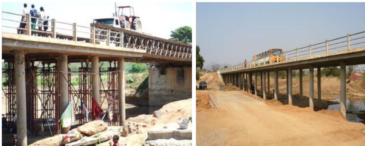
Figura 20 - Ponte sobre o rio Caimbambo durante a fase de reabilitação (Conduril, s.d.)
