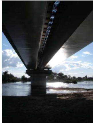
Figura 24 - Vista inferior do tabuleiro da ponte sobre rio Cunene em Xangongo (Miranda, 2011)
