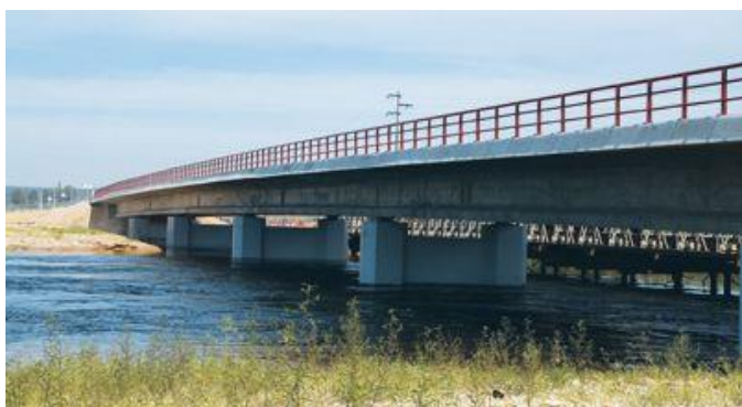
Figura 26 - Nova ponte sobre o rio Cuito (Ribeiro, 2016)
