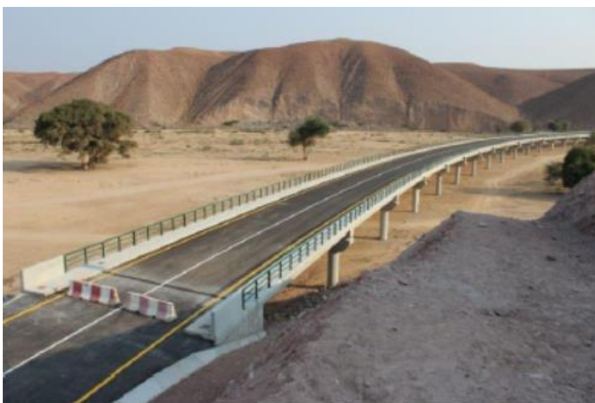
Figura 30 - Ponte sobre o rio Giraul (Telhabel, Construções)
