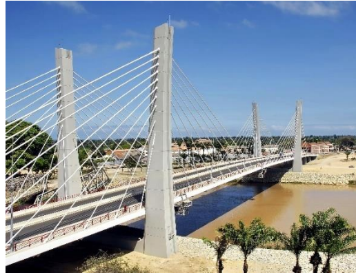
Figura 67 - Ponte 4 de Abril, vista da margem esquerda (Armando Rito Engenharia, S.A)
