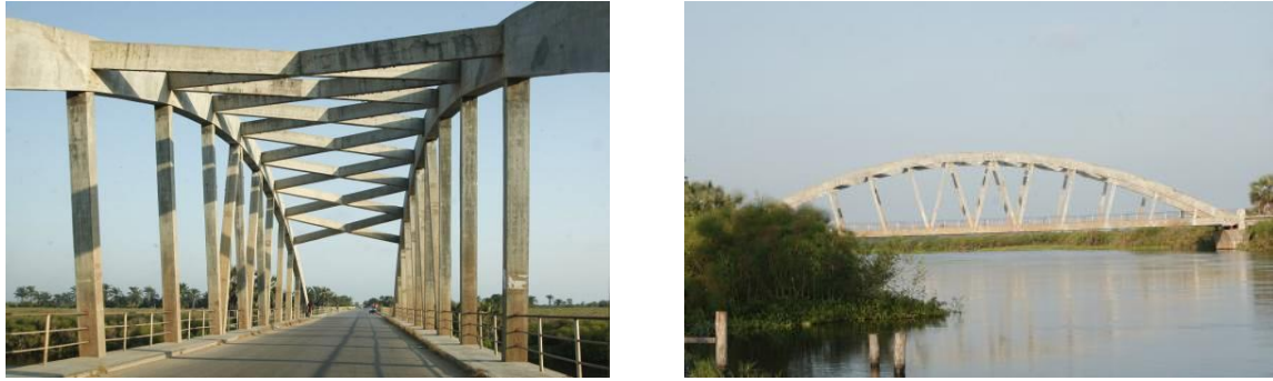
Figura 39 - Ponte sobre o rio Longa
