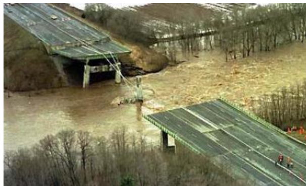
Figura 52 - Colapso da ponte sobre o ribeiro Schorarie (LPESA)
