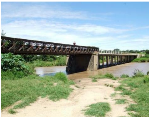
Figura 19 - Ponte sobre o rio Caimbambo com ponte metálica provisória (Conduril, s.d.)
