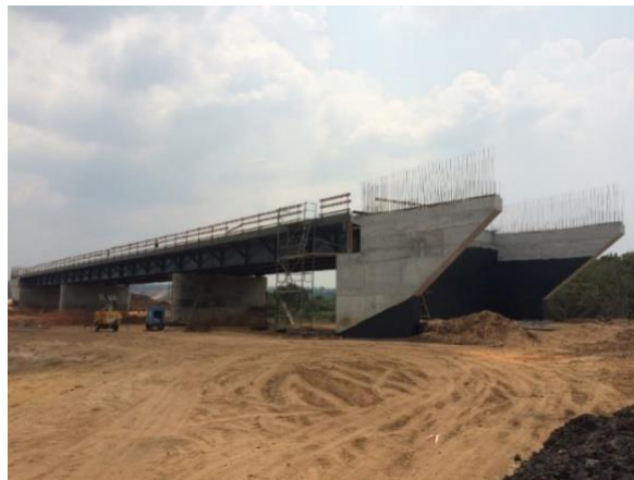
Figura 44 - Ponte sobre o rio Cuilo na fase de construção, solução de tabuleiro com vigas metálicas (COBA)
