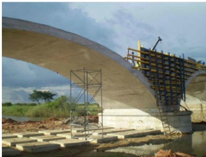
Figura 14 - Parte do processo de reabilitação da ponte sobre o rio Kwanza na Cangandala (Conduril, s.d.)
