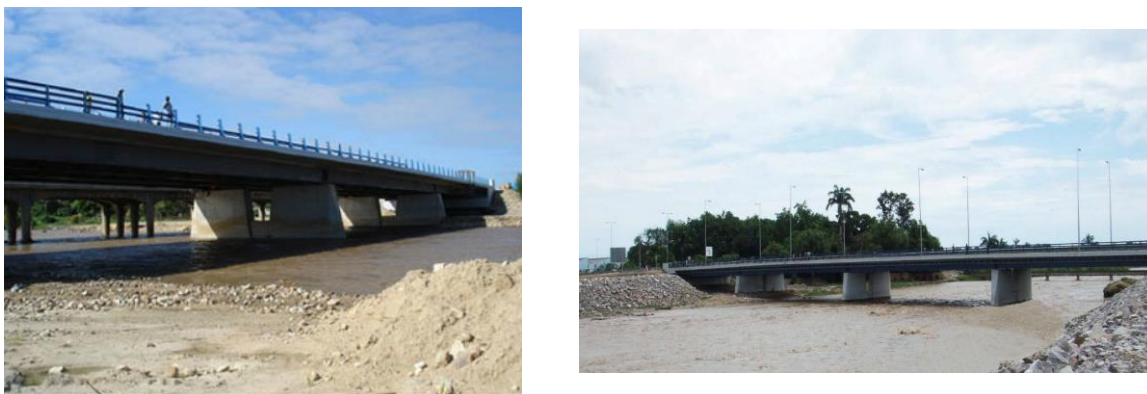
Figura 21 - Nova ponte sobre o rio Cavaco, em Benguela (Conduril, s.d.)
