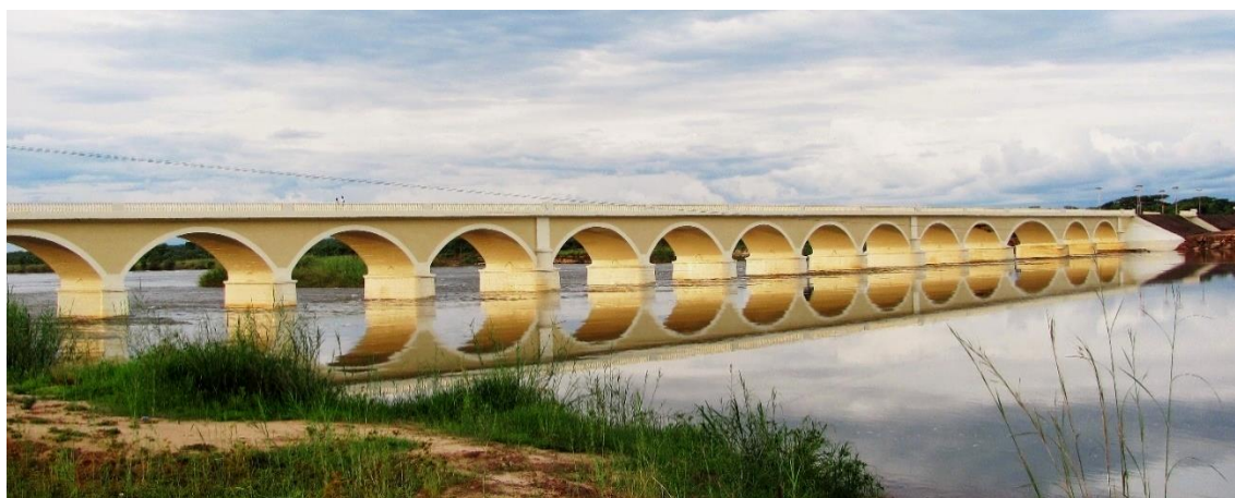
Figura 15 - Ponte sobre o rio Kwanza, em Cangandala reabilitada entre 2008 e 2010 (Armando Rito Engenharia, S.A)
