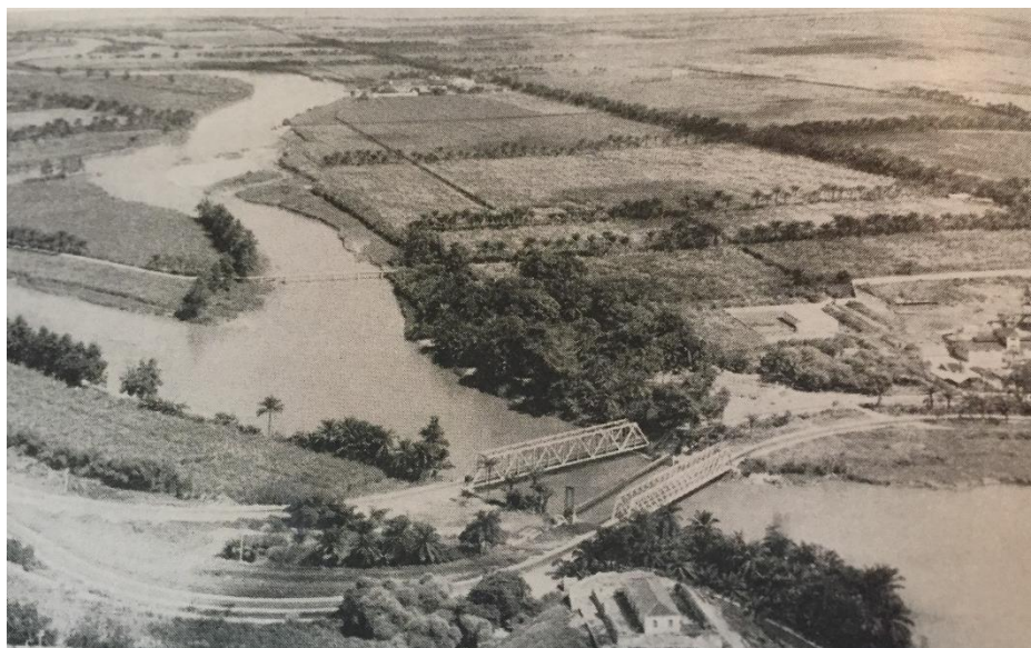
Figura 7 - Pontes sobre o rio Catumbela (Landerset & Perloiro, 1964)
