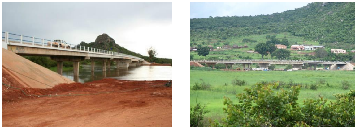
Figura 16 - Ponte sobre o rio Queve (Armando Rito Engenharia, S.A) (Conduril, s.d.)
