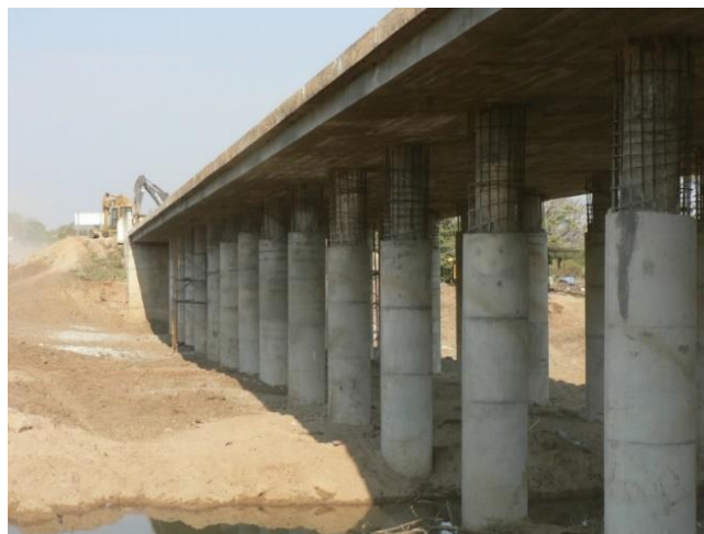
Figura 45 - Ponte sobre o rio Caimbambo durante a fase de reabilitação, solução de tabuleiro de laje de betão armado maciça (Armando Rito Engenharia, S.A)
