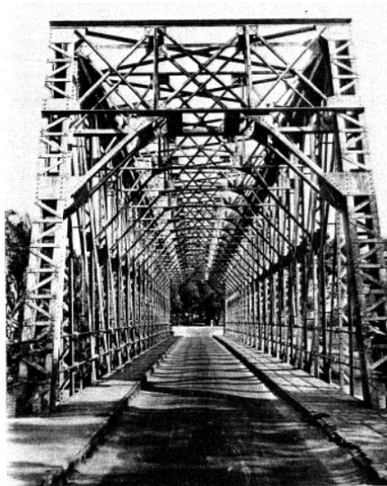
Figura 5 - Ponte “Luís Filipe” sobre o rio Catumbela depois de ser reconvertida para o tráfego rodoviário (Landerset & Perloiro, 1968)
