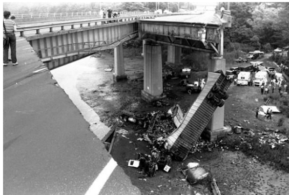
Figura 51 - Colapso da ponte sobre rio Mianus (LPESA)
