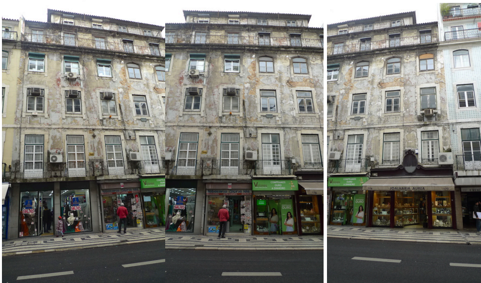
Figura 57. Edifício na Rua do Ouro, 172; fachada, antes da reabilitação (2016).
