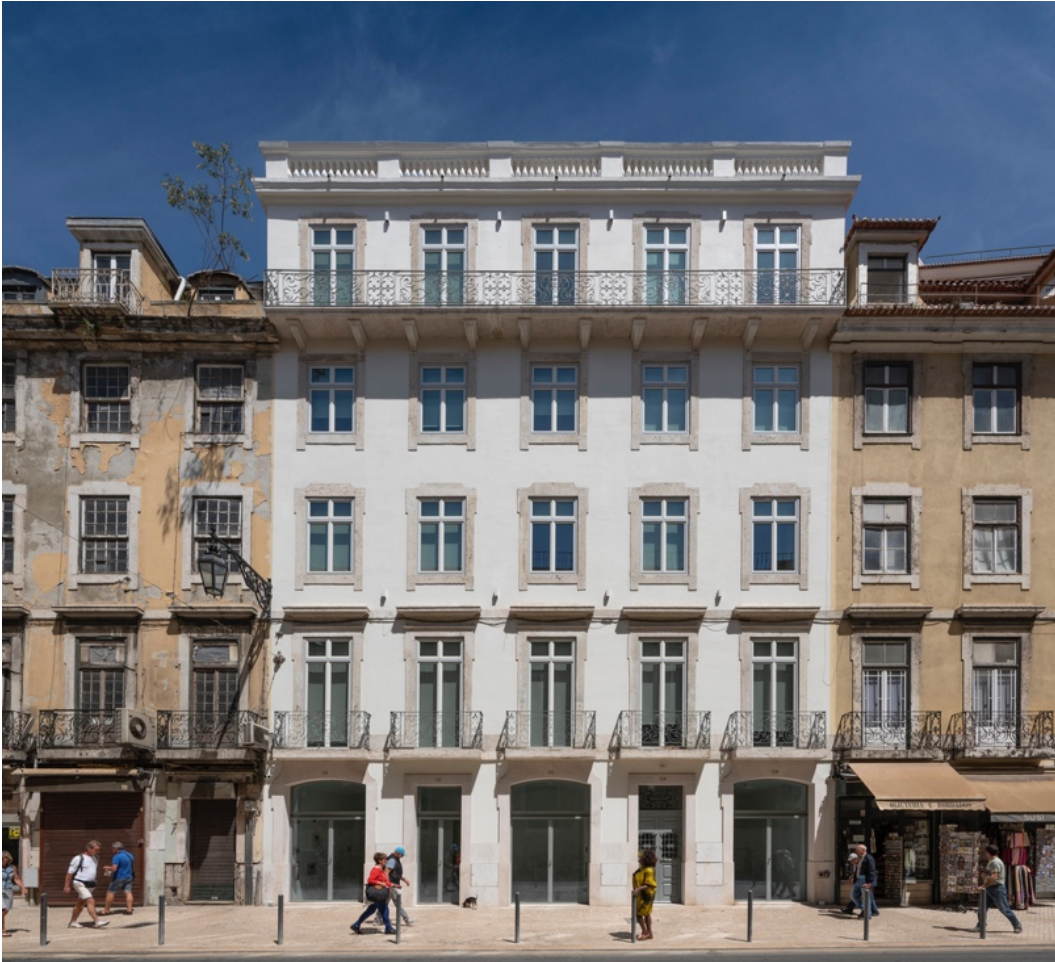
Figura 45. Edifício na Rua do Arsenal, 108; fachada, após reabilitação (2018).
