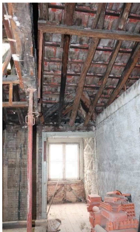
Figura 29 – Condição atual do último piso
