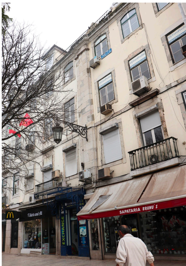
Figura 22. Condição atual da fachada contígua à Praça D. Pedro IV, datável da década de 1760.
