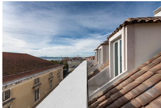
Figura 47. Edifício na Rua do Arsenal, 108; aspeto das trapeiras, após reabilitação (2018).
