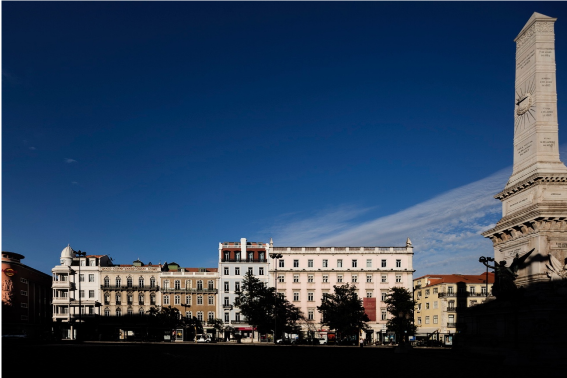
Figura 52. Edifício na Praça dos Restauradores, 53-56; fachada, após reabilitação (2017).
