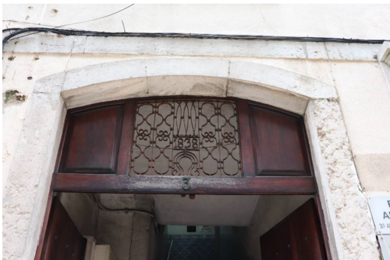
Figura 24 - Porta principal da fachada posterior, voltada para a Rua Dom Antão de Almada, com data de construção, 1838.
