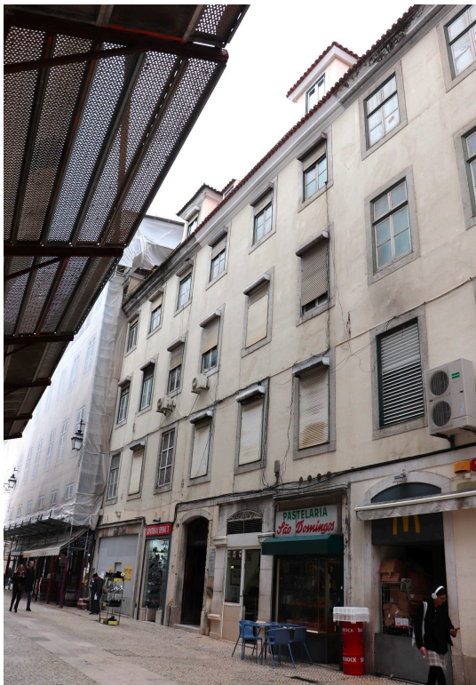
Figura 23. Condição atual da fachada contígua à Rua Dom Antão de Almada, datável da década de 1830.
