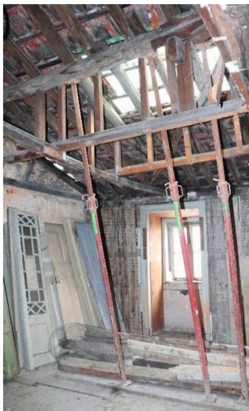
Figura 28 – Condição atual do último piso
