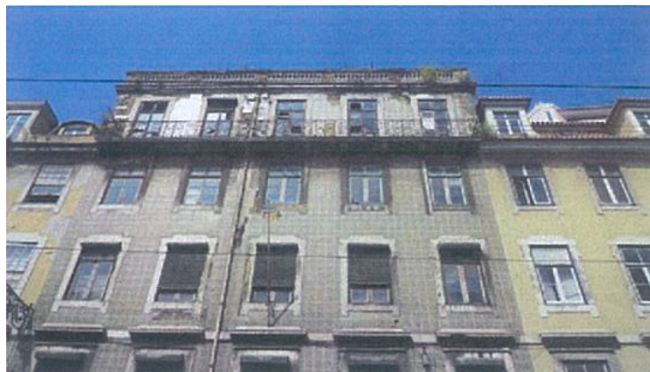
Figura 39. Edifício na Rua do Arsenal, 108; aspeto da fachada antes da obra (2014).
