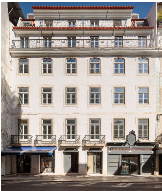
Figura 64. Edifício na Rua do Ouro, 172; fachada, após reabilitação (2020).
