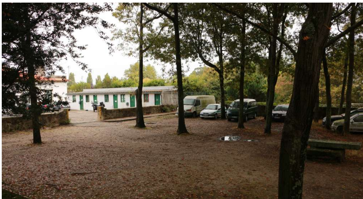
Fig.75 – Construção no Terreno
