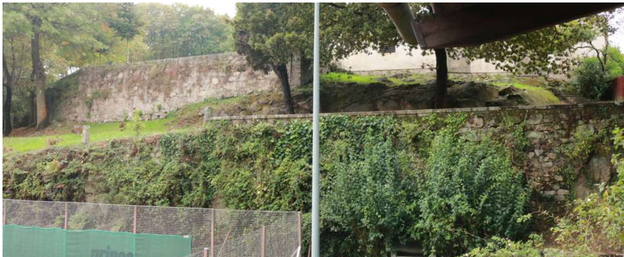
Fig.68 – Localização do Terreno
