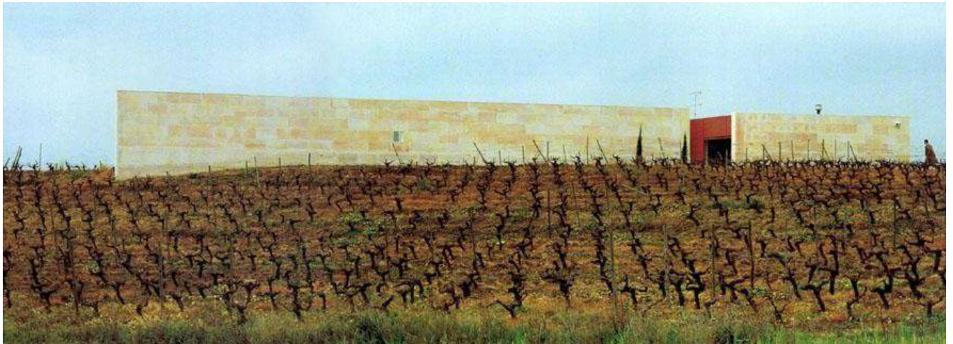
Fig.30 – Fachada em Pedra
