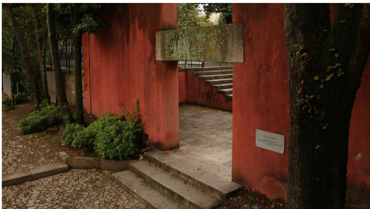
Fig.66 – Continuidade da Escadaria
