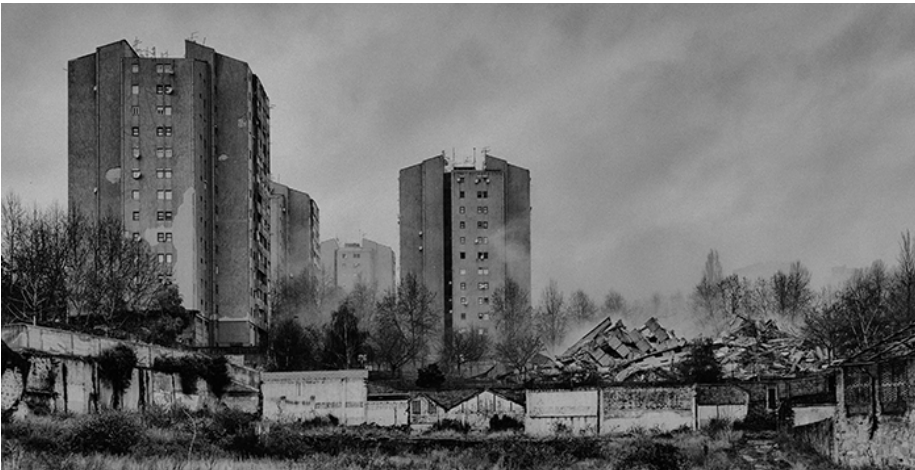
Fig. 28 - Demolição torre E. Fonte: http://arquivo2.jornalarquitectos.pt/aleixo-sempre/
