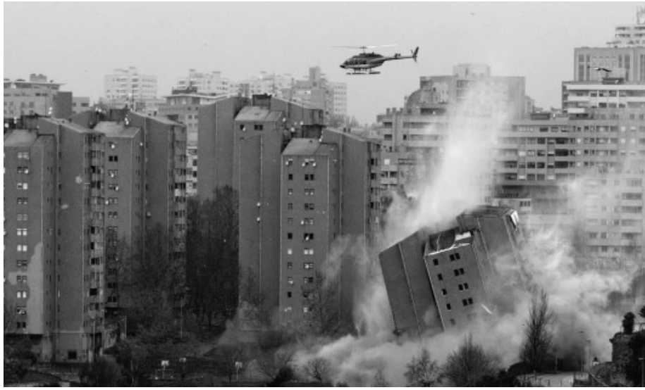
Fig. 26 – Demolição do Aleixo. Fonte: Silva, P. 2023. p. 62.
