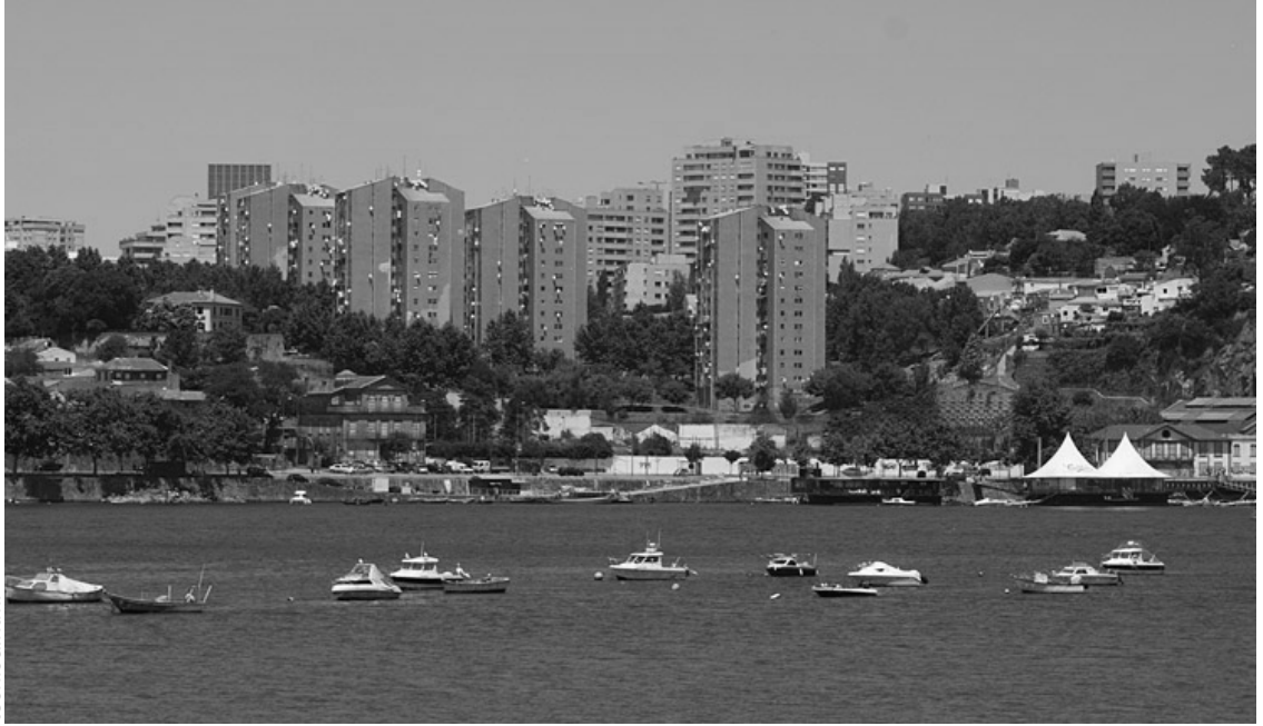
Fig. 24 - Impacto do Aleixo. Fonte: https://samuelcantigueiro.blogspot.com/2011/12/bairro-do-aleixo-perfeicao-tecnica.html
