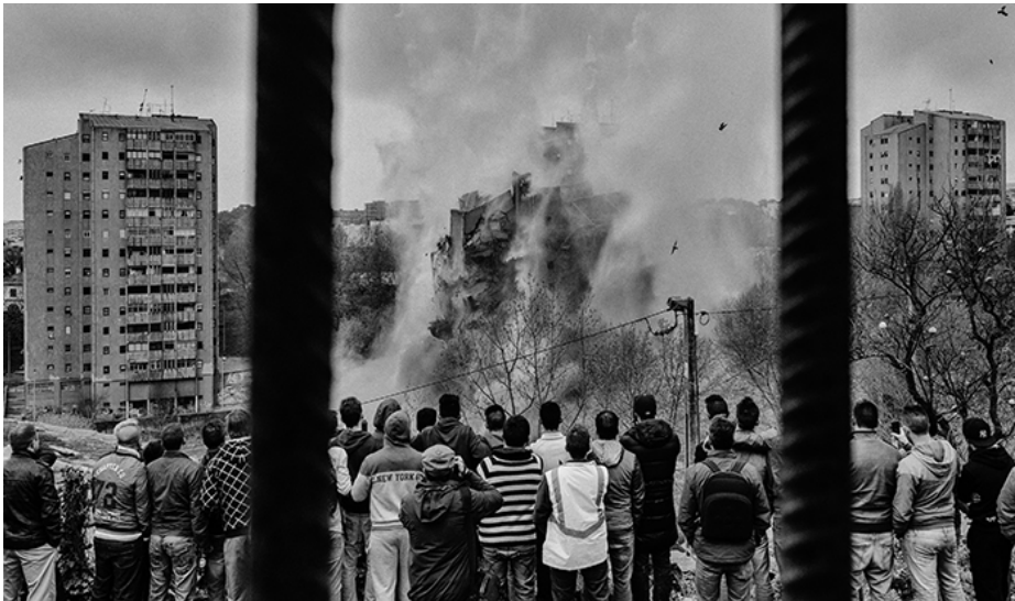
Fig. 27 – Demolição torre D. Fonte: http://arquivo2.jornalarquitectos.pt/aleixo-sempre/
