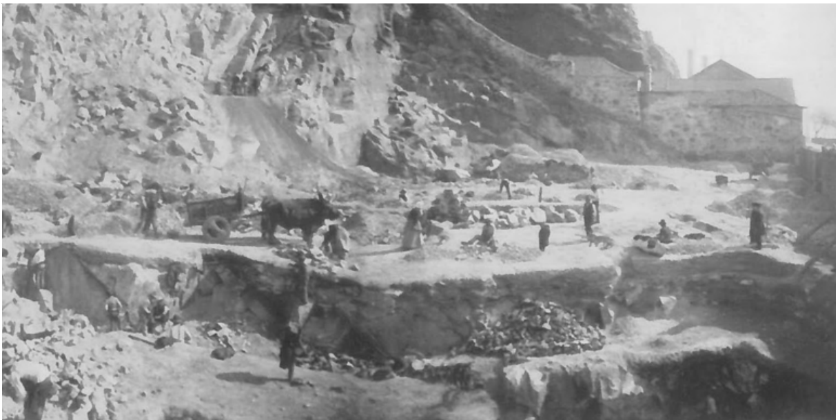
Fig. 6 - Trabalhos no terreno. Fase de construção. Fonte: Miranda, F. 2016. p. 200
