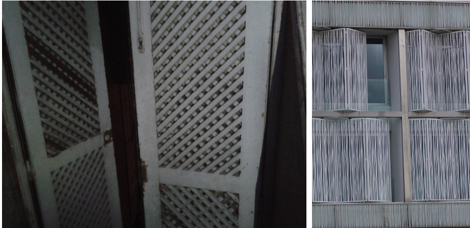
FIG. 3 e 4 - Rótula interior em casa pombalina na Rua da Palma 1 a 15 em Lisboa e em vãos exteriores no Hotel Altis Belém
