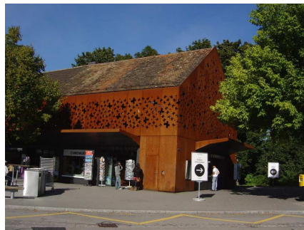
FIG 5 e 6 - Grelhagem de adobes para a circulação do ar em Marrocos, cerca de Ouarzazate e Grelhagem de aço Corten em Neuhausen, cataratas do Reno, Suíça
