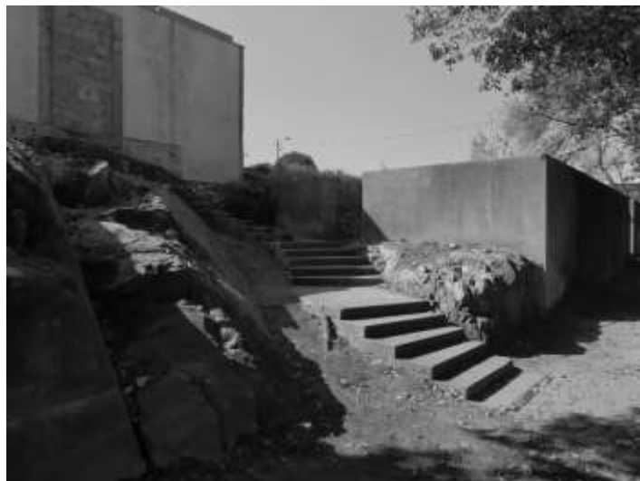
Figura 43 - escada integrada em afloramento rochoso Fonte: Professor Francisco Portugal e Gomes
