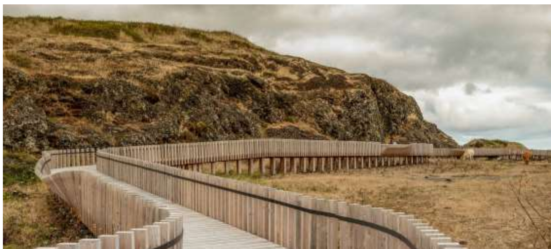
Figura 2- Passadiço Pedreira do Campo, Açores Autor da imagem: Artur Silva
