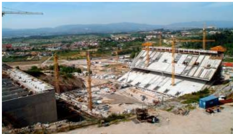
Figura 39- Construção do Estádio. Fonte:scbraga.pt/estadio/
