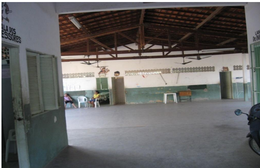
Figura -1 Área Interna da Escola
