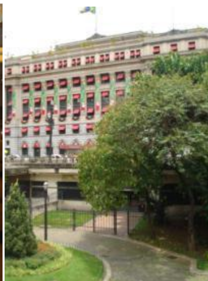
Figura 75- Vista do Viaduto do Chá,
