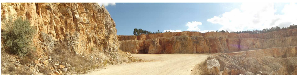
Figura 42. Acesso ao interior da zona sul de desmonte da pedreira da Serra de Atouguia. 2018.
