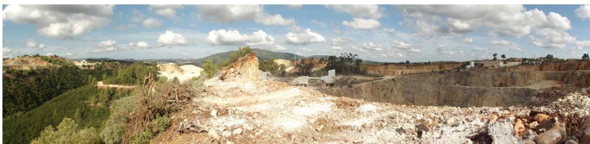
Figura 26. Duas realidades em coexistência, a pedreira e a paisagem protegida do vale cársico.
