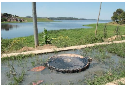
Figura 10 – Entrada em carga com extravasamento (RBA, 2014)
