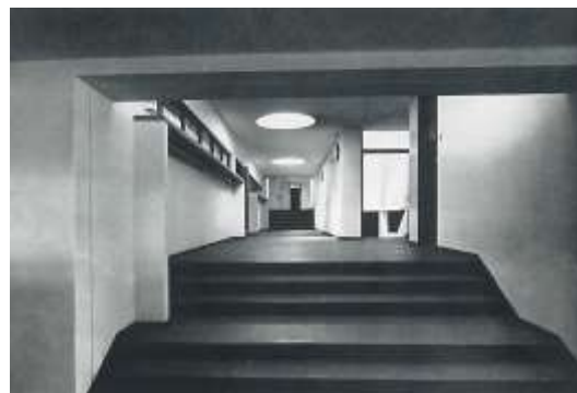
Fig. 45: Pormenor da galleria - revista Arquitectura nº125, 1972, p. 54
