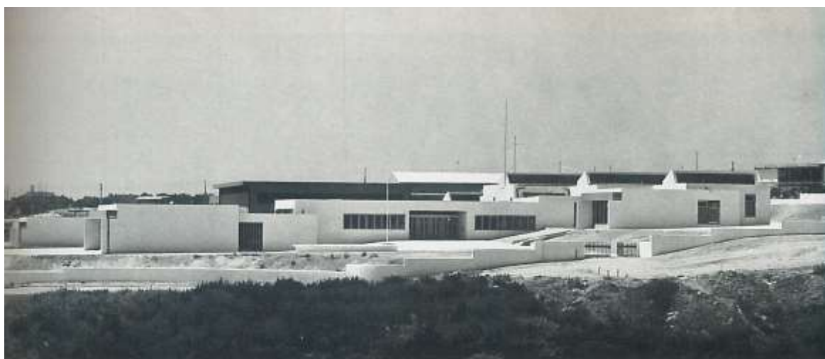
Fig.43: Escola Primária em Chelas, Lisboa – revista Arquitectura nº125, 1972, p.49
