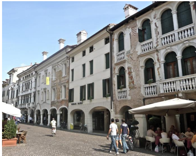
FIG. 1: Arcades in Corso Vittorio Emanuele, Pordenone. ©LMFFabris
