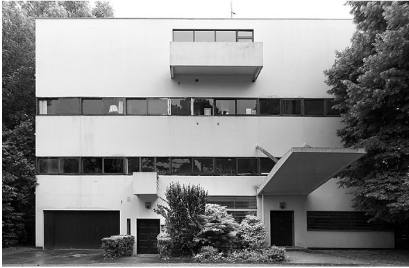
Figura 38 – Fotografia alçado principal
