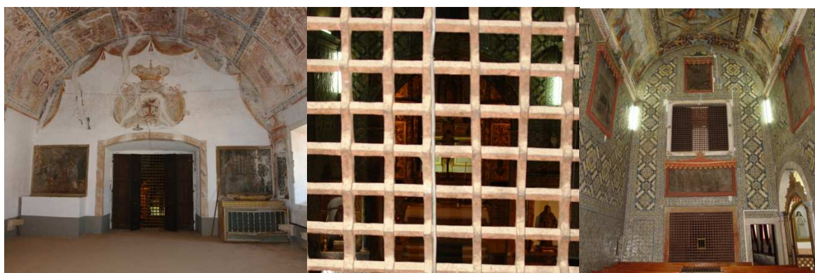
Vista sobre a nave da igreja do coro alto para a nave da igreja (figuras 33 e 34) e vista da nave da igreja, para os coros alto e baixo da igreja do Mosteiro de Nossa Sra. da Esperança de Vila Viçosa (figura 35).
