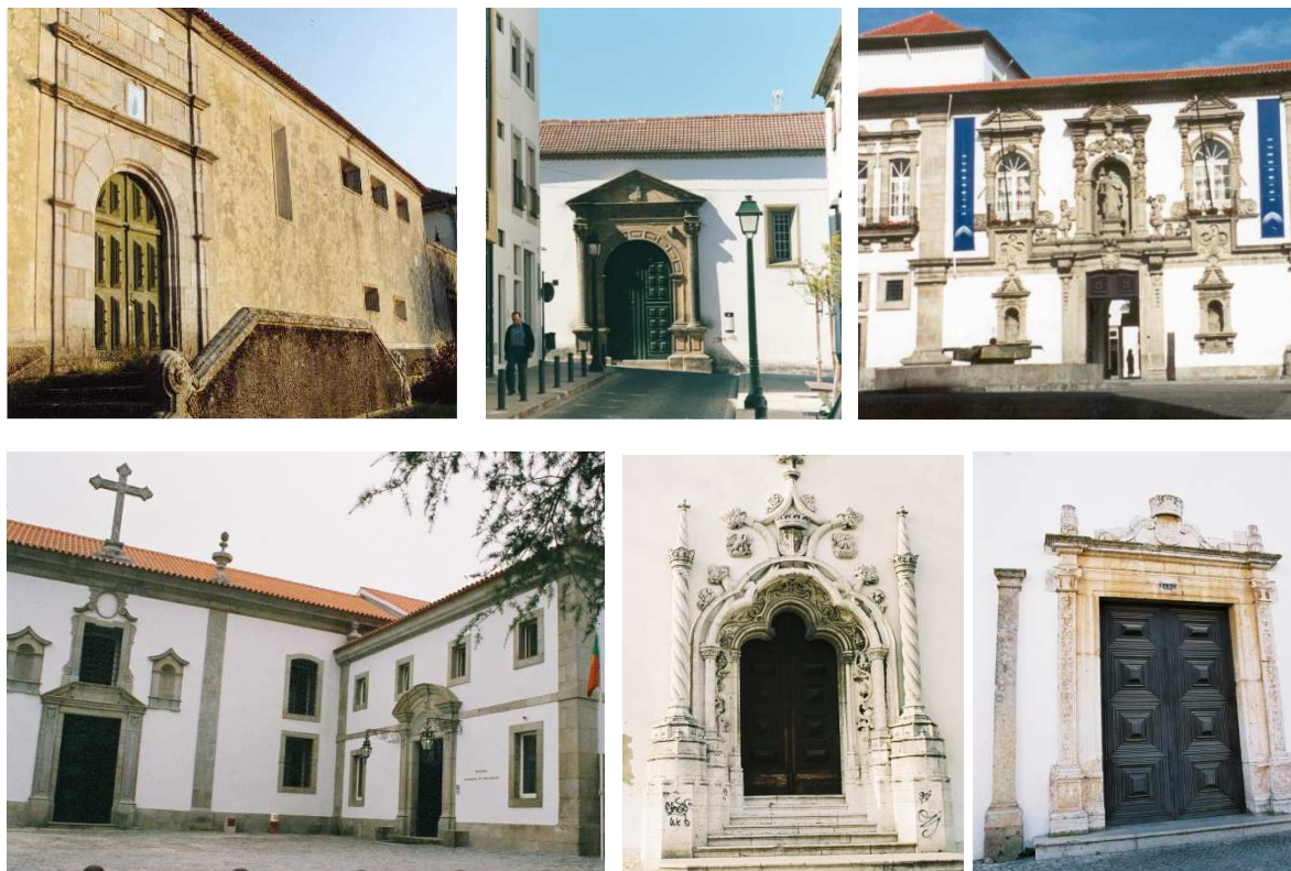
Figura10 - Porta da igreja do Mosteiro de N. Sra. das Misericórdias, Caminha. Figura 11 - Porta da igreja do Mosteiro de S. Clara, Bragança Figura 12 - Porta da portaria do Mosteiro de S. Clara,
