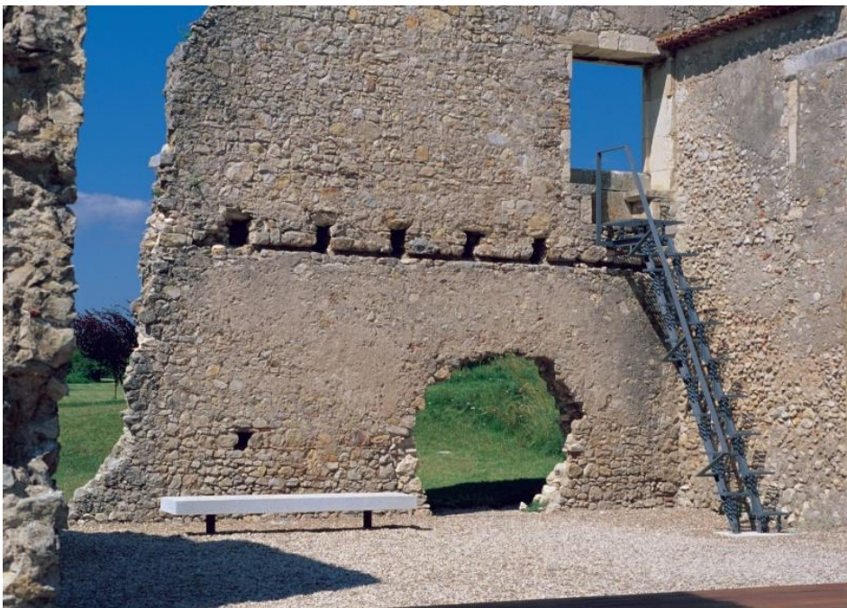
Figura 25 | Intervenção de João Mendes Ribeiro (Casa de Chá, Montemor-O-Velho, Coimbra)
