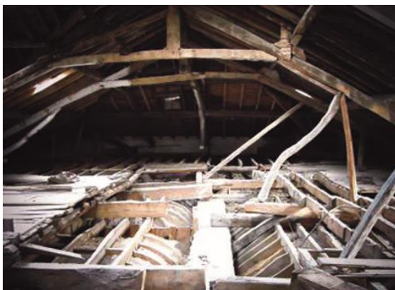
Figura 61| Cobertura aquando da pré-existência da Casa da Escrita, Coimbra
