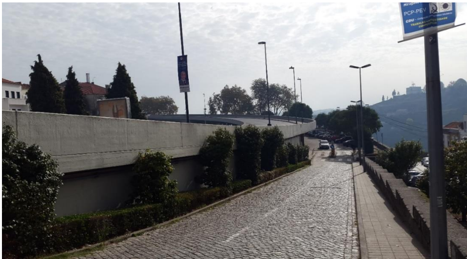
Figura 8| Fotografia do parque de estacionamento localizado por baixo do viaduto da Rua do General Sousa Dias
