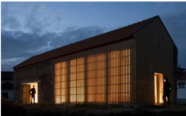
Figura 35| Vista exterior Palheiro na Cortegaça, Mortágua, Viseu, após intervenção
