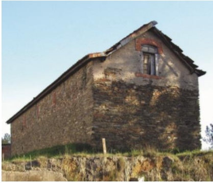
Figura 37| Fotografia da pré-existência, Palheiro na Cortegaça, Mortágua, Viseu
