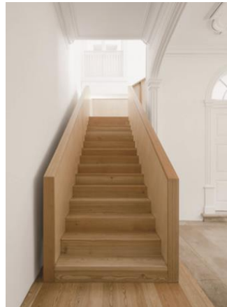
Figura 72| Escada após a intervenção na Casa da Escrita, Coimbra
