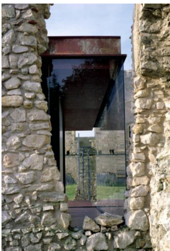
Figura 29| Vista exterior da Casa de Chá, Montemor-O-Velho, Coimbra
