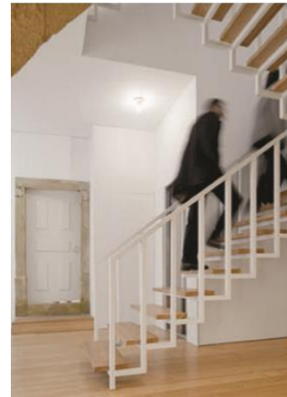
Figura 73| Escada secundária após intervenção na Casa da Escrita, Coimbra
