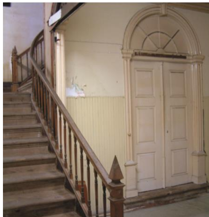
Figura 71| Escada principal aquando da pré-existência, Casa da Escrita, Coimbra
