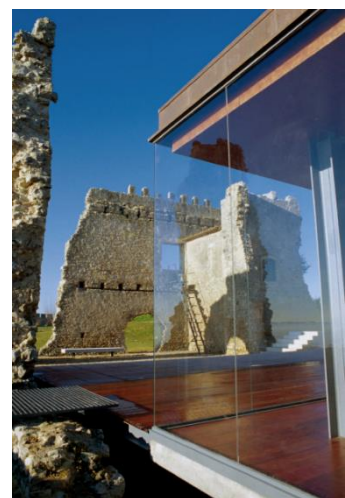
Figura 31| Vista exterior da Casa de Chá, Montemor-O-Velho, Coimbra
