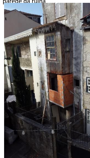
Figura 18| Fotografia do alçado tardoz do edificado vizinho
