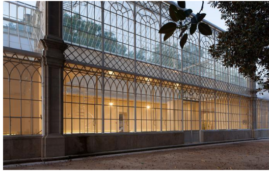
Figura 83| Vista exterior após a intervenção na Estufa do Jardim Botânico, Coimbra
