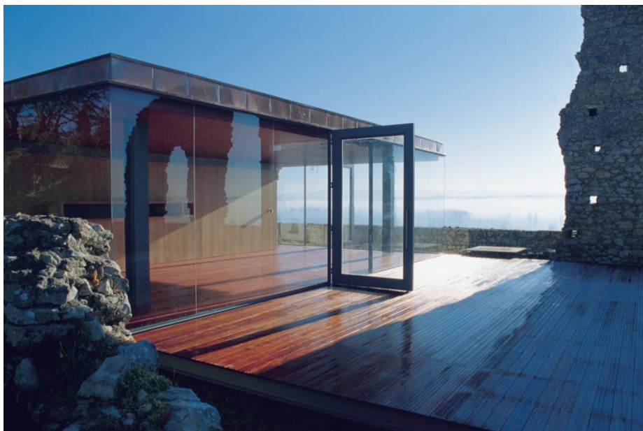
Figura 32 | Vista exterior da Casa de Chá, Montemor-O-Velho, Coimbra
