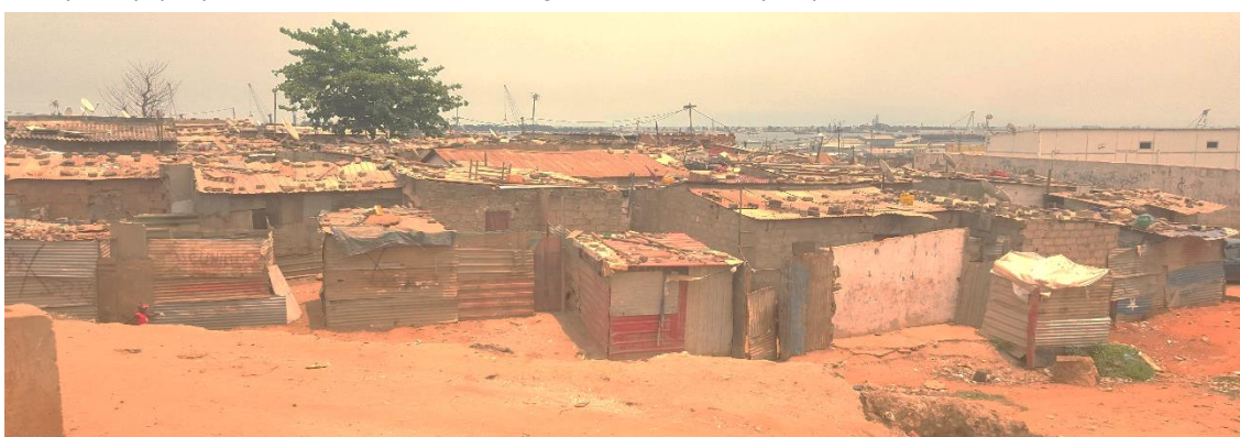
Fig. 44 – Foto de um dos bairros informais de Luanda, Boa Vista no caso, com as construções em bloco de cimento e chapa de zinco. Percebe-se também a escala das construções, muito reduzidas, e o agregado irregular.
