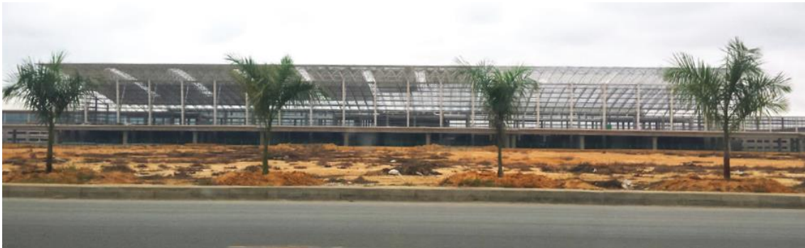
Fig. 73 – Futuro aeroporto de Luanda, ainda em construção ((PDGML) P. D., 2015, p. 164)
