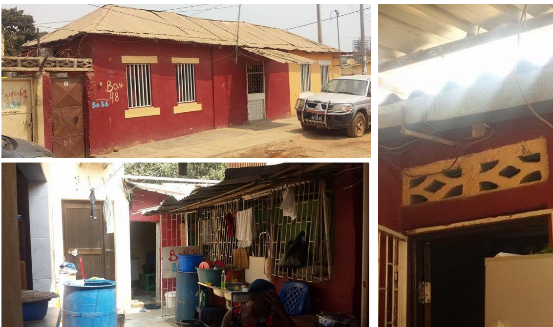
Fig. 52 – Habitação 3, neste caso o corpo principal também compreende duas habitações atualmente. Na foto de baixo podemos observar a cozinha exterior, e os vários anexos que hoje ocupam o quintal quase que anulando-o. Do lado direito um pormenor em bloco de cimento, localizado em cima da porta, ajuda a ventilar. Uma prática corrente.
