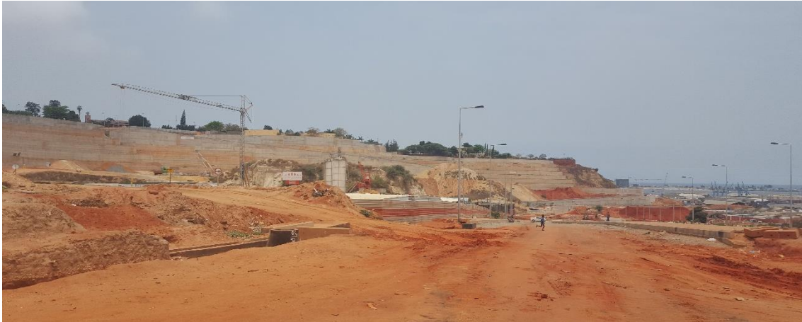
Fig. 79 – Foto das obras de requalificação da Boavista
