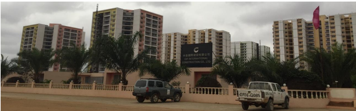
Fig. 78 – Foto com enquadramento dos prédios do Zango
