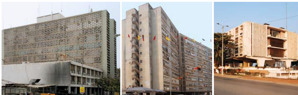
Fig. 30 – Do lado esquerdo, o Bloco da Mutamba projetado pelo arquiteto Vasco Vieira da Costa (Pedro, et al., 2011, p. 36). Fig. 31 – Ao centro, a foto do Prédio do Livro do bairro São Paulo, distrito urbano do Sambizanga (Pedro, et al., 2011, p. 16). Fig. 32 – Do lado direito, foto do antigo hotel Panorama na Ilha de Luanda (Pedro, et al., 2011, p. 43)
