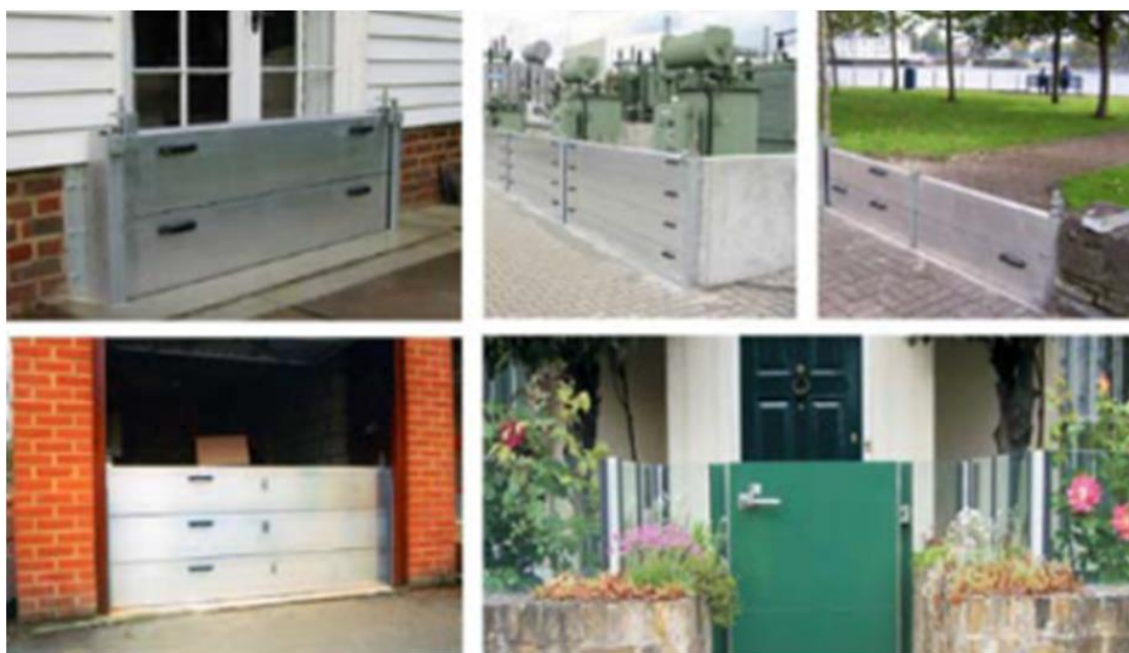
Figura 25 - Exemplos de barreiras desmontáveis contra inundações. (APA, Plano de Gestão dos Riscos de Inundações, 2015)
