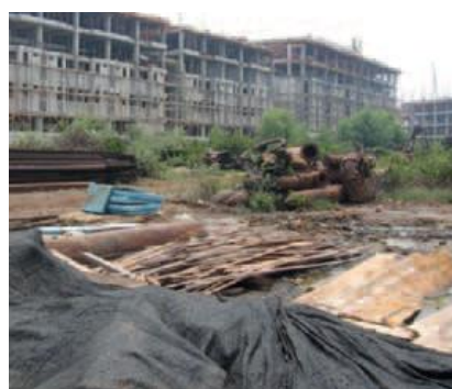
Figura 10 - Construção de Habitações de baixo custo visando reduzir a vulnerabilidade dos moradores de favelas (Group, 2011)
