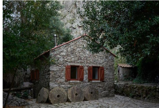
Figura 69- Vista exterior (S)
