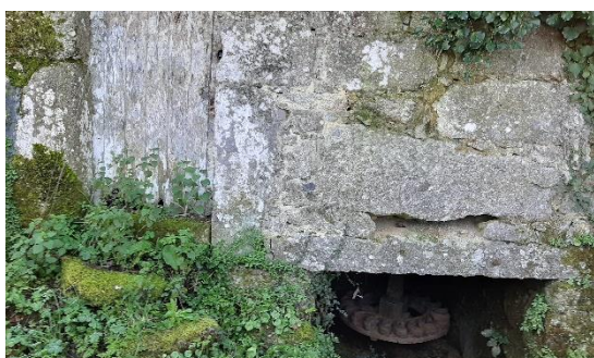
Figura 47- Pormenor exterior da alvenaria de pedra ordinária
