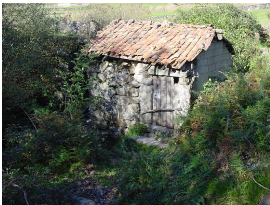
Figura 33- Moinho da Ponte do Moinho antes da conservação
