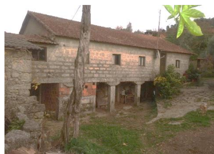
Figura 17- Casa da lavoura. Terras de Bouro
