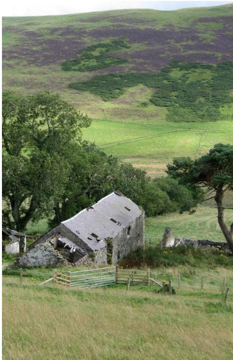
Figura 88- Moinho antes da intervenção
