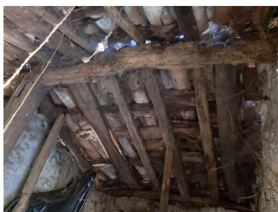
Figura 52- Pormenor interior da cobertura
