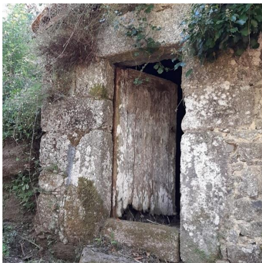
Figura 49- Pormenor exterior da verga e ombreiras
