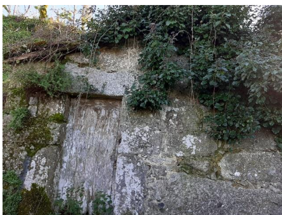
Figura 51- Pormenor exterior da cobertura
