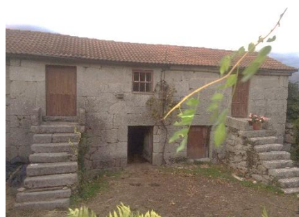
Figura 18- Casa da lavoura. Terras de Bouro
