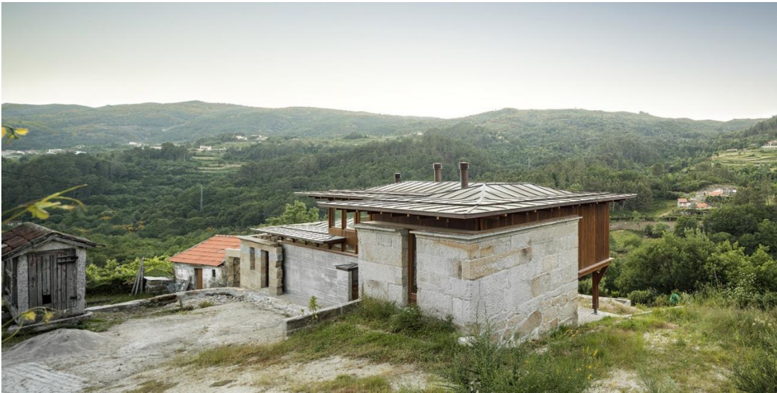
Figura 122- Casa Costa Grande
