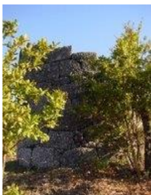
Figura 35- Moinho de vento em ruínas
