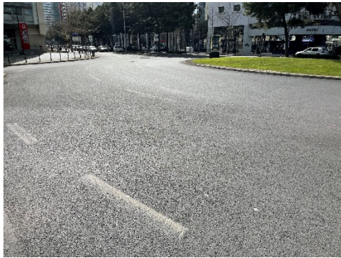
Figura 2.4 – Pavimento em bom estado
