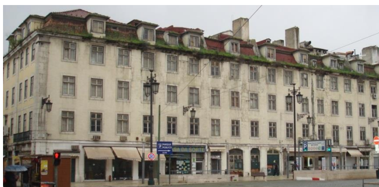
Figura 52 – Fachada Nascente – Praça da Figueira (2014)
