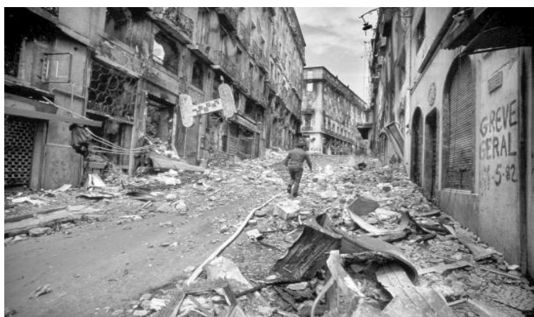
Figura 17 – Incêndio do Chiado – Lisboa (1988). Acedido em 3 de fevereiro de 2014 em http://www.tvi24.iol.pt
