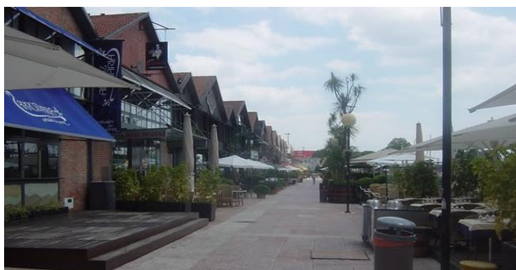
Figura 10 – Pavilhões das Docas de Lisboa. Acedido em 6 de novembro de 2013 em http://www.skyscrapercity.com
