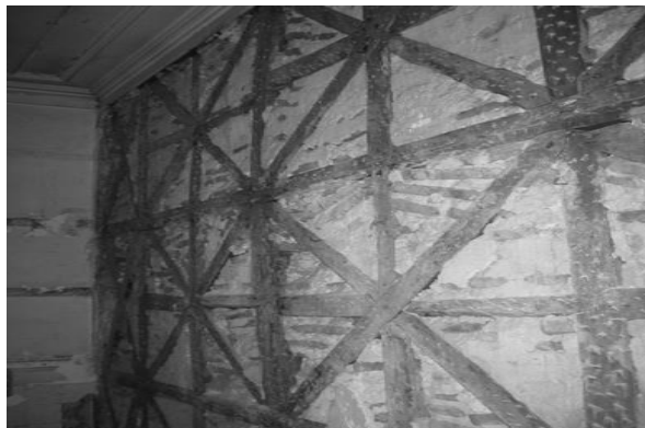
Figura 48 – (À Esq.) Parede Meeira em Gaiola.
