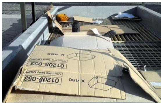
Figura 37 – Sem Abrigo no Ventilador
