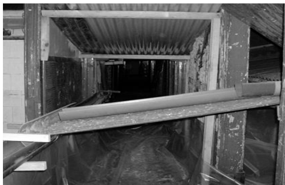
Figura 53 – Drenagem de Águas no piso
