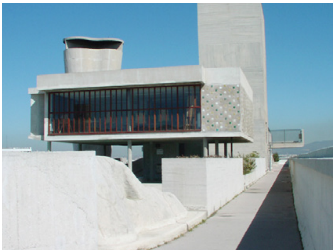
Figura 45. Escola Infantil na Cobertura.
