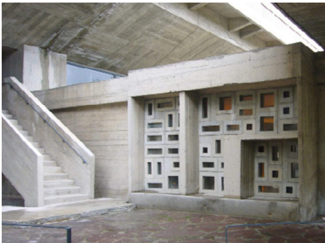
Figura 44. Fachada Norte da Entrada Principal e Entrada para as Zonas Técnicas e Serviços.
