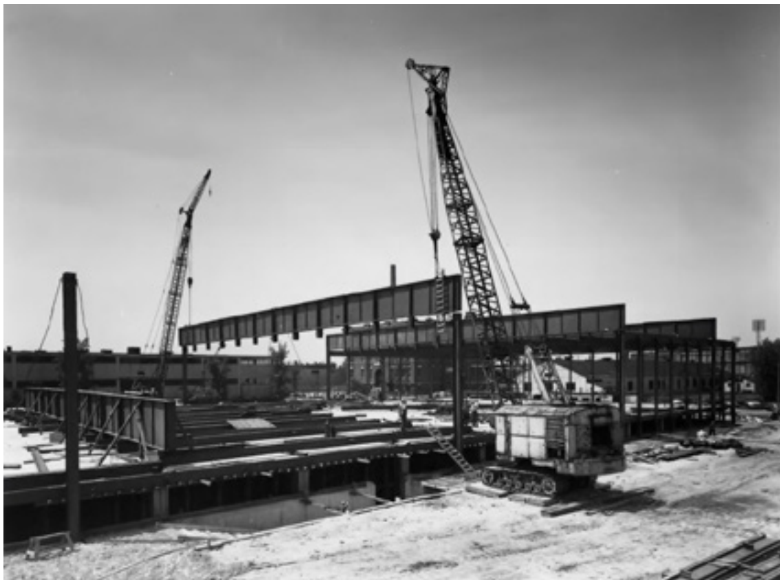
Figura 67. Fase de construção dos elementos estruturais.
