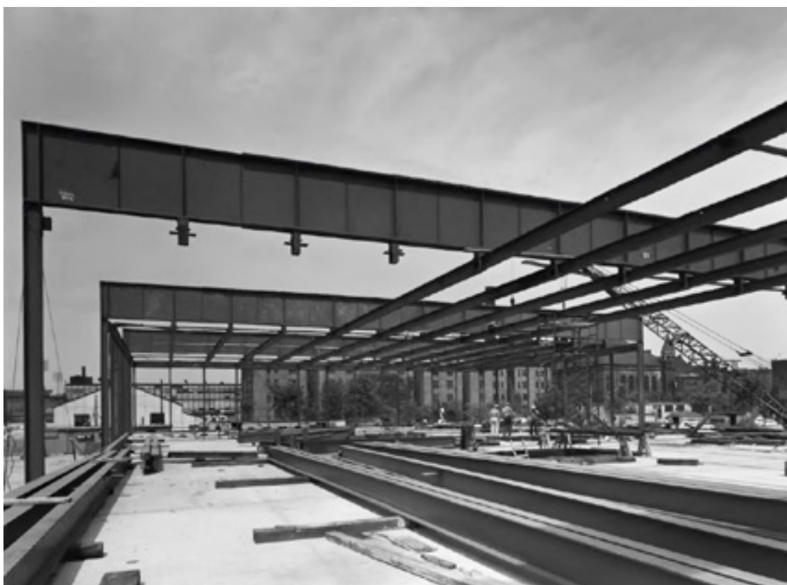
Figura 68. Fase de construção dos elementos estruturais.
