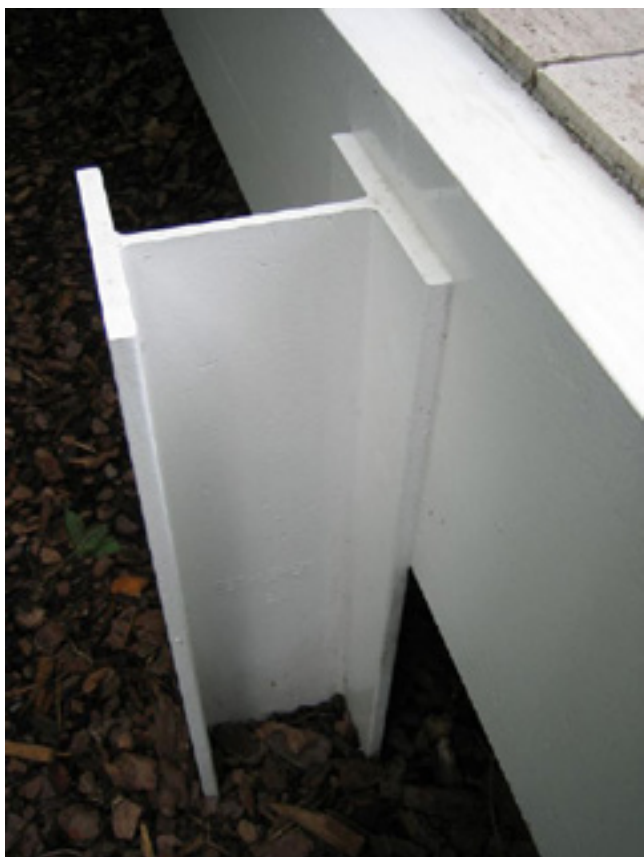
Figura 37. Coluna de aço em forma de I.
