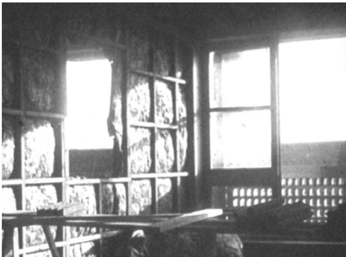
Figura 57. Sistema Construtivo, em construção.
