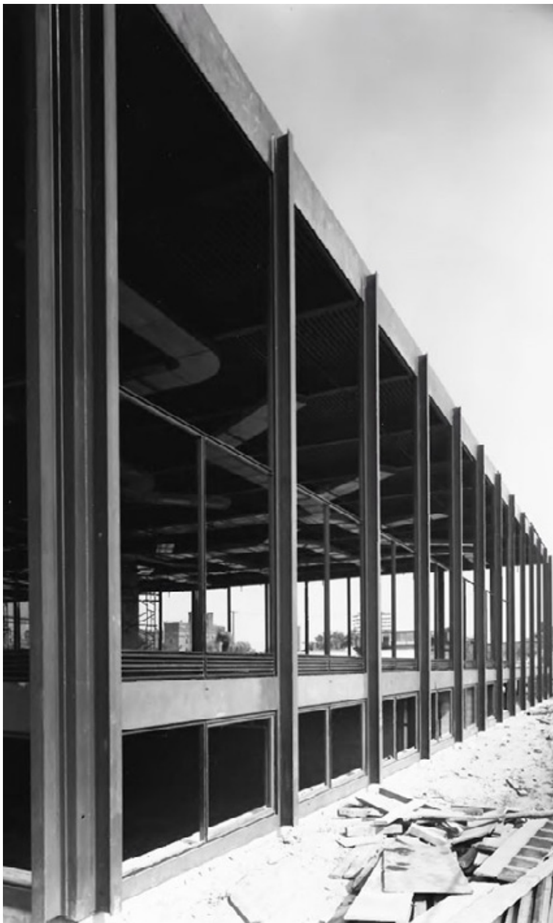
Figura 69. Fachada em construção.
