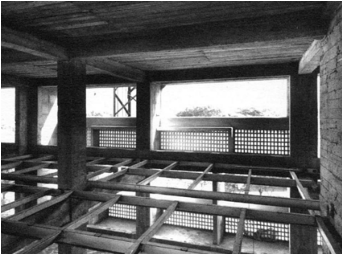
Figura 55. Sistema Construtivo, em construção.
