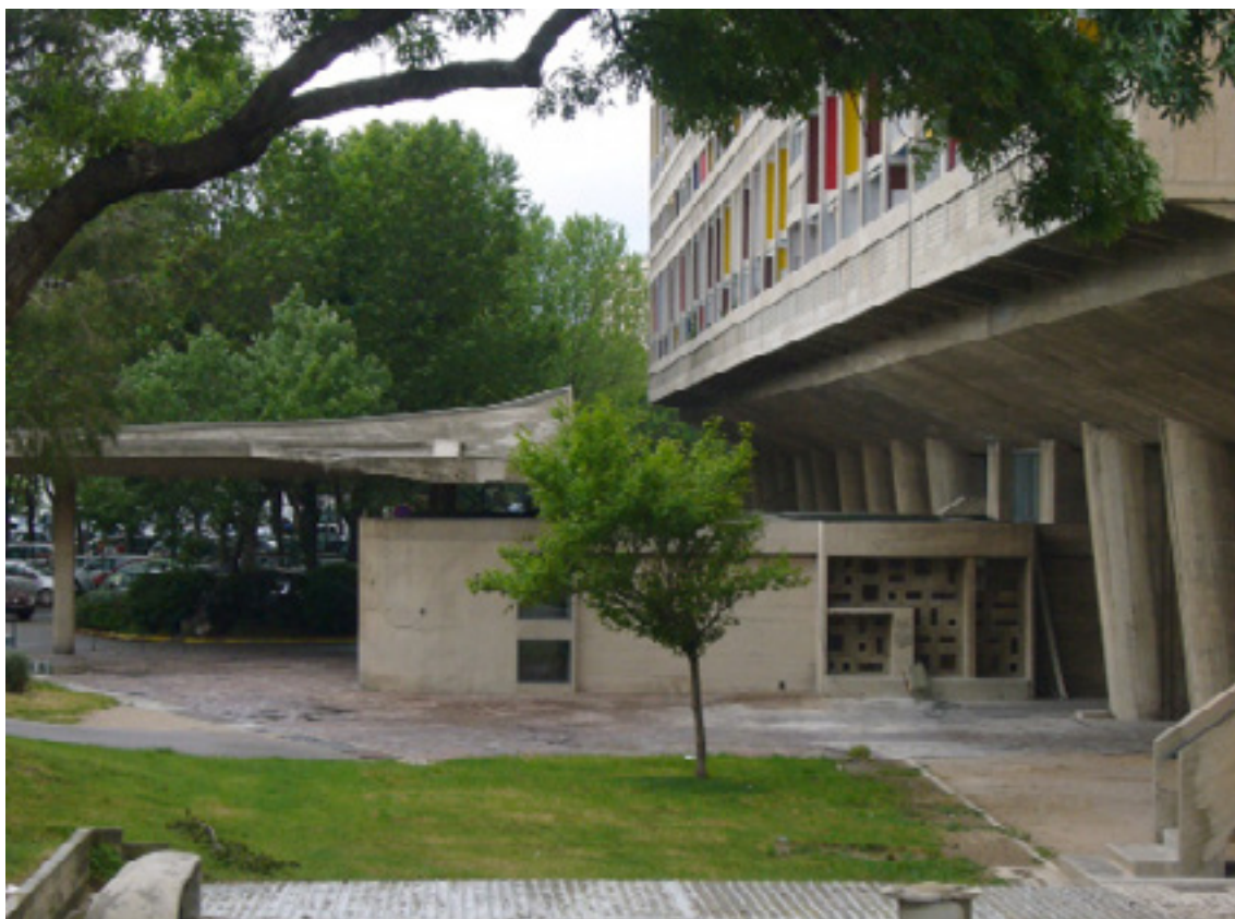
Figura 46. Fachada exterior Sul e pala de Betão da entrada principal da Unidade de Habitação.
