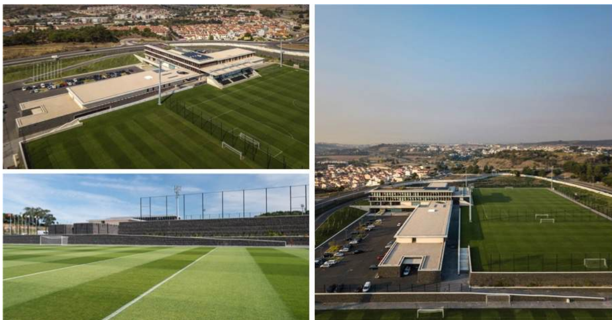
Figura 14 - Espaço exterior do Centro Técnico da FPF
