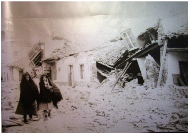
Fig. 22 - A destruição provocada pelo sismo de 1909. (s/d). Fonte: http://fotos.sapo.pt/fotosamora/perfil . Acedido em 10 agosto 2016
