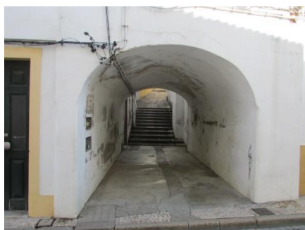
Fig. 37 - A Travessa do Arco. (Autor, 2016).
