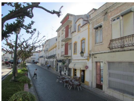
Fig. 43 - Conjunto de edifícios alinhados que conforma a Praça a sul. (Autor, 2016).
