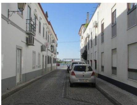
Fig. 35 - Travessa Porto João Ferreira. (Autor, 2016).
