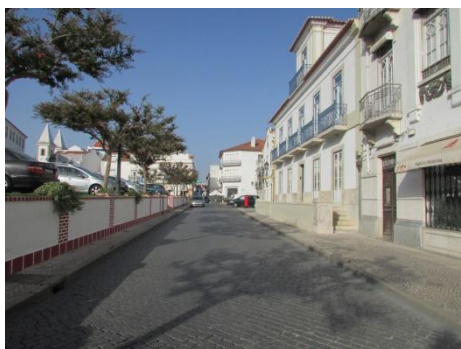
Fig. 44 - Edifício com cota de soleira mais elevada. (Autor, 2016).
