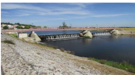
Fig. 60 - Açude insuflável que controla o nível do espelho de água em frente à Vila e a ponte pedonal. (Autor, 2016)
