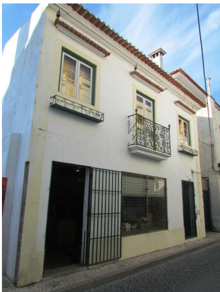
Fig. 33 - Construção ocupada na Rua Direita. (Autor, 2016).
