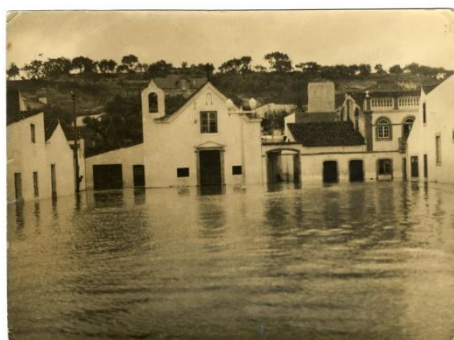
Fig. 26 - Inundações no Largo de Santo António no ano de 1907. (s/d). Fonte: Museu Municipal de Coruche.
