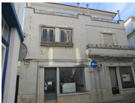
Fig. 34 - Construção devoluta na Rua Direita. (Autor, 2016).
