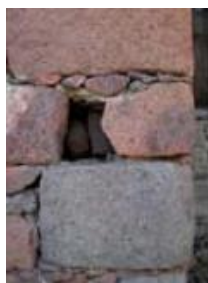
Fig. 3- Pormenor da parede ventilada (Guedes, 2011, p. 111).
