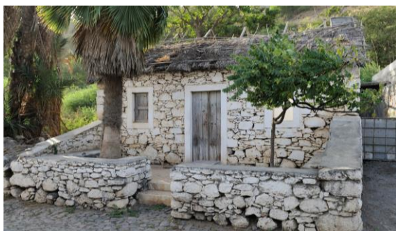
Fig. 23- Casa vernacular na Rua da Banana 4 , Cidade Velha, Santiago (Cayambe, 2011).
