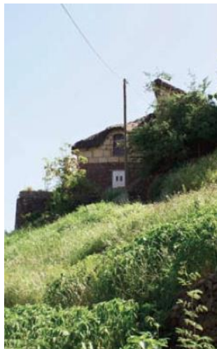
Fig. 1- Vista da fachada Noroeste (Guedes, 2011, p. 110).
