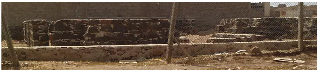
Fig. 25- Construção de uma casa em pedra basáltica na ilha do Sal, Cabo Verde (Neves, 2014, p. 24).
