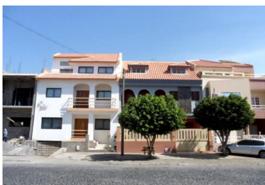
Fig. 28- Moradias Unifamiliares num bairro nobre, na cidade da Praia (Inocêncio, 2012, p. 25).
