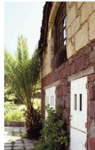
Fig. 2- Vista da fachada Noroeste (Guedes, 2011, p. 110).
