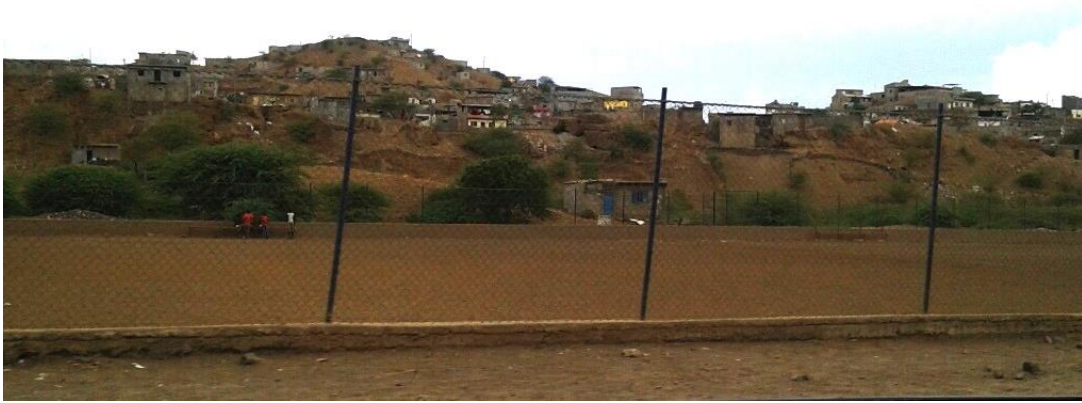
Fig. 46 – Fotografia da cidade da Praia, onde é visível a localização onde as casas são construídas, Autoria do autor.
