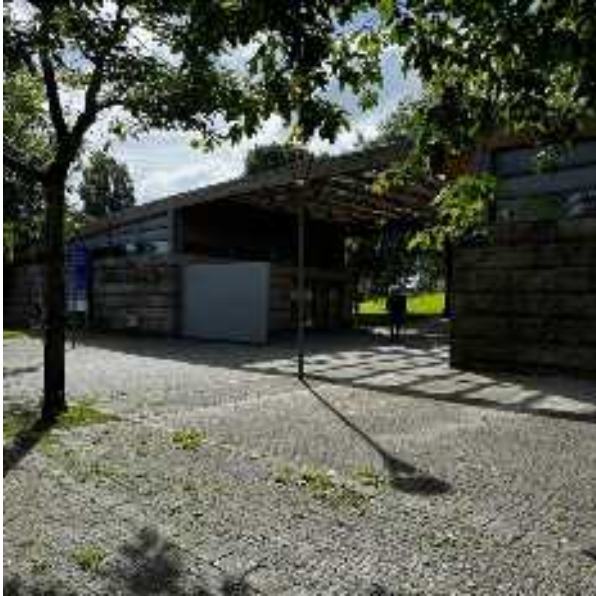
Figura 3- Entrada Norte-Parque da Pasteleira (Fonte: autora)
