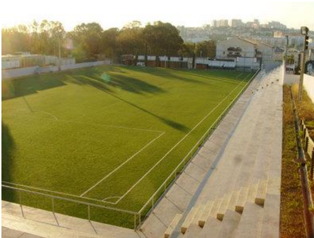
Figura 2. Complexo Desportivo Bairro da Boavista.
