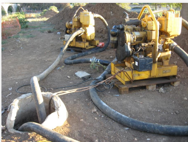
Figura 50 – Tubagem flexível de sucção dos caudais da caixa de visita a montante do troço a intervir (MANVIA, 2009)
