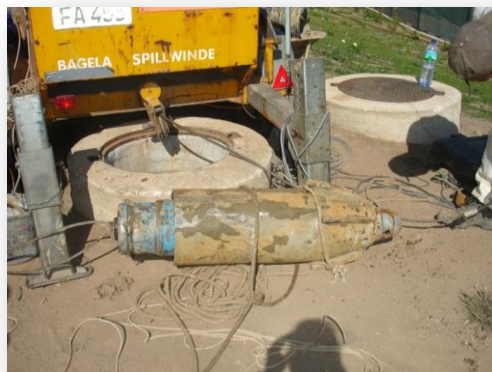
Figura 91 – Cabeça de rebentamento pneumática (antes de depois do entubamento por rebentamento) – Caso de Estudo 2
