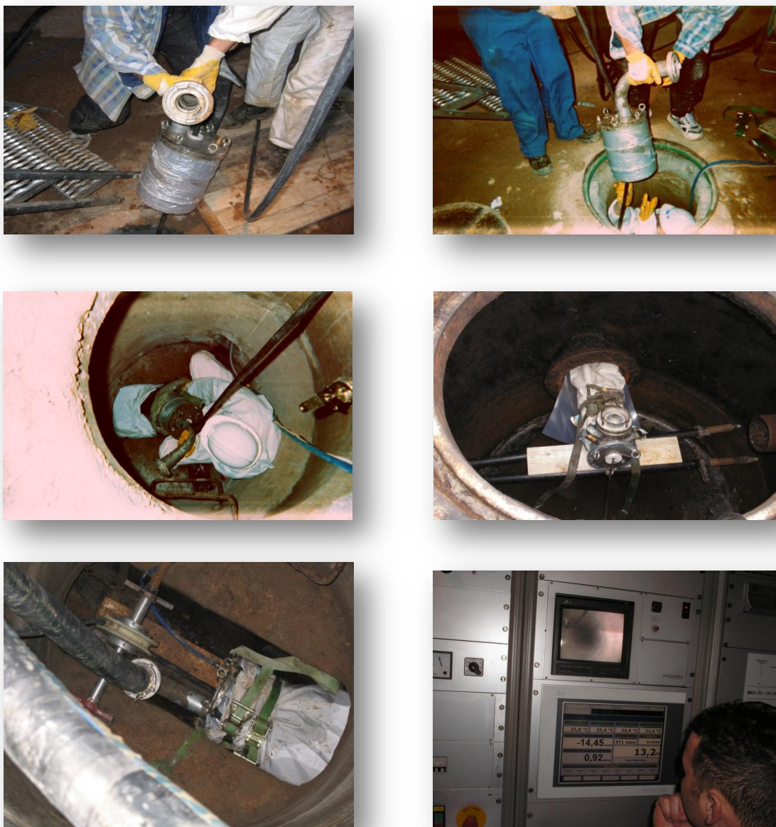
Figura 70 – Fases de insuflação de ar na manga e controlo da pressão – Caso de Estudo 1
