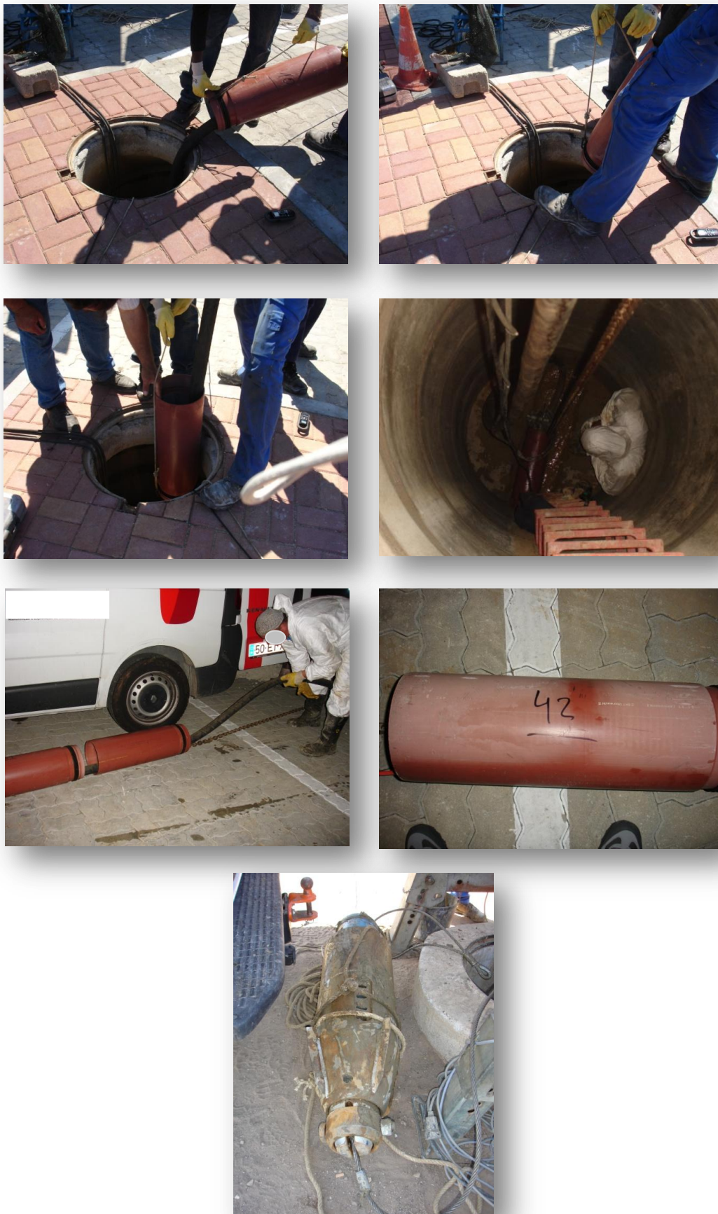
Figura 93 – Fases de execução do entubamento por rebentamento dinâmico (1º caso realizado em Portugal) – Caso de Estudo 2
