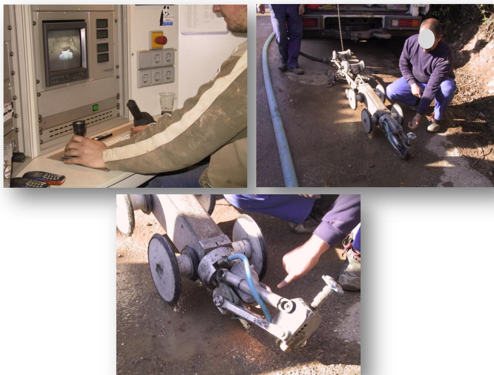
Figura 64 – Equipamento robot fresador com câmara de inspecção vídeo – Caso de Estudo 1
