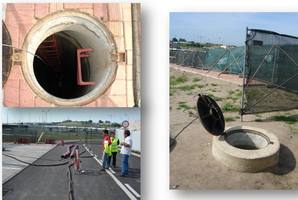
Figura 76 – Caixas de visita montante e jusante referente ao troço a reabilitar – Caso de Estudo 2
