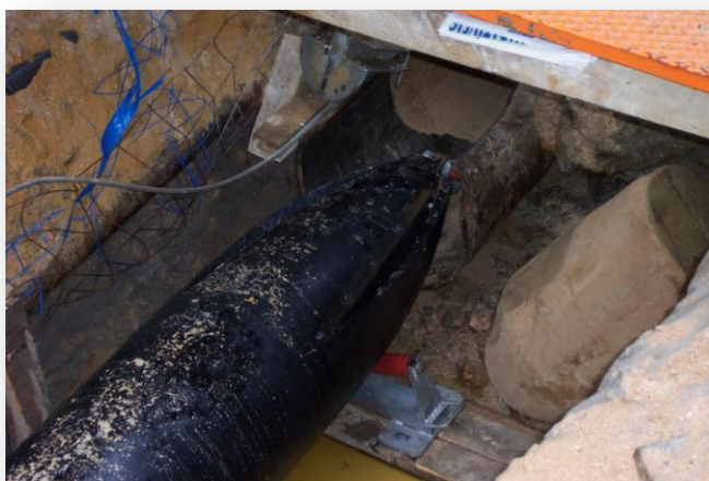
Figura 36 – Pormenor do poço de entrada da tubagem sendo visível o colector existente após limpeza e a extremidade tronco-cónica do novo tubo de Polietileno de Alta Densidade (PEAD) (MANVIA, 2006)
