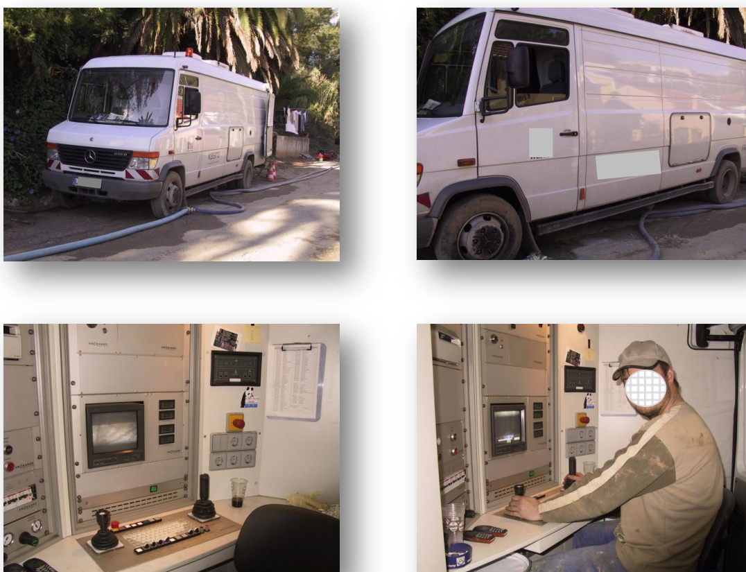
Figura 62 – Pessoal e equipamento próprio da PFEIFFER-MANVIA para a execução do encamisamento contínuo através da cura da manga de reabilitação em Poliéster Reforçado com Fibras de Vidro (PRFV) por radiação ultravioleta (UV) – Caso de Estudo 1
