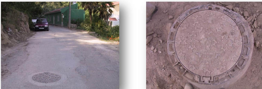
Figura 65 – Caixas de visita acessíveis – Caso de Estudo 1
