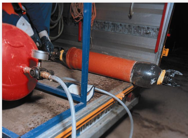
Figura 14 – O êmbolo é expandido no local danificado comprimindo a manga impregnada de resina (MANVIA, 2006)
