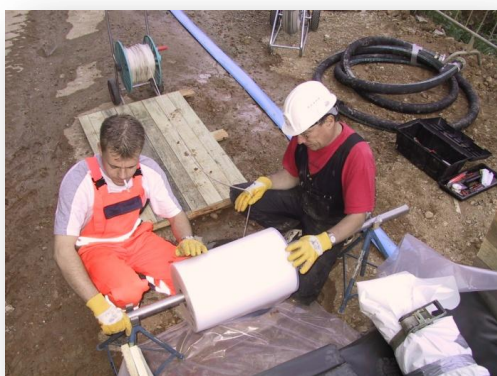
Figura 67 – Fases da inserção da manga no troço do colectora a reabilitar – Caso de Estudo 1
