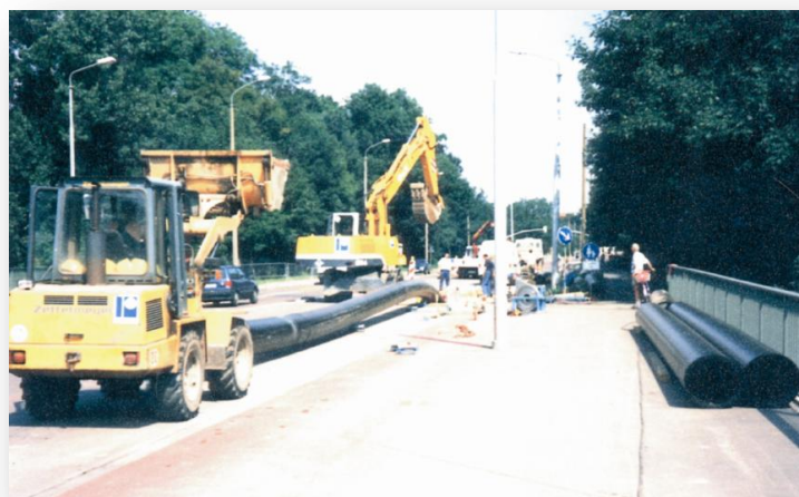
Figura 38 – Pormenor do processo de inserção visto do poço de entrada da tubagem (MANVIA, 2006)
