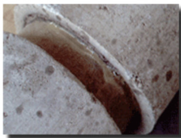
Figura 11 – Corte na tubagem hospedeira, sendo observável no seu interior o tubo de resina de silicatos (MANVIA, 2006)
