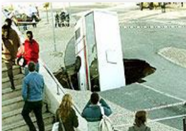
Figura 4 – Colapso de uma rede de drenagem (MANVIA, 2009)
