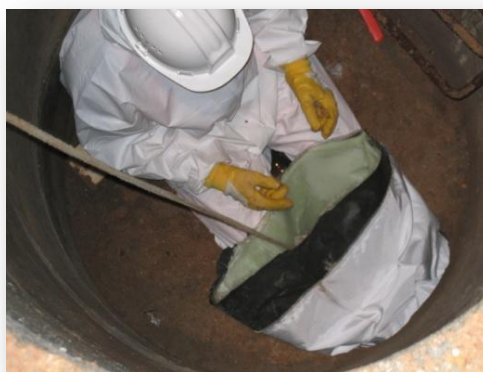
Figura 68 – Entrada da manga na caixa de visita e posteriormente no colector efectuada de forma lenta e controlada - Caso de Estudo 1
