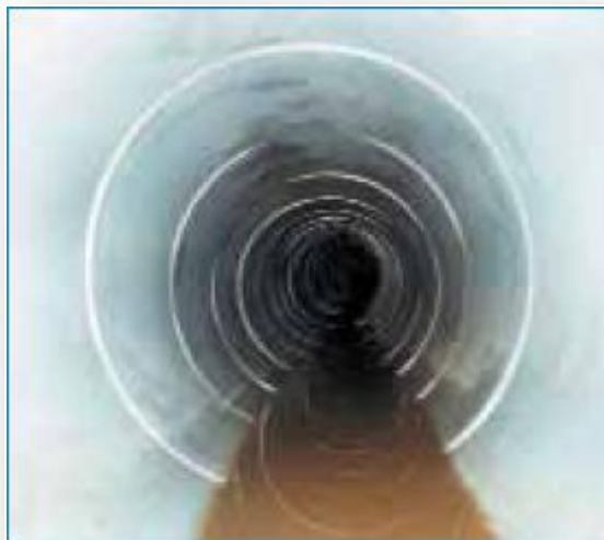
Figura 48 – Resultado após « relining » com tubos EGEPLAST (MANVIA, 2009)
