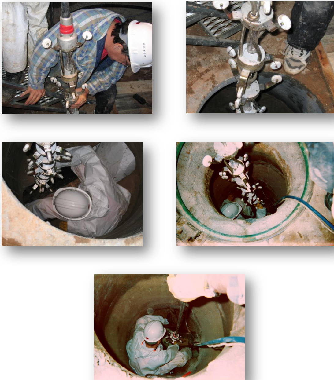
Figura 72 – Introdução do conjunto de lâmpadas ultravioletas (UV) - Caso de Estudo 1
