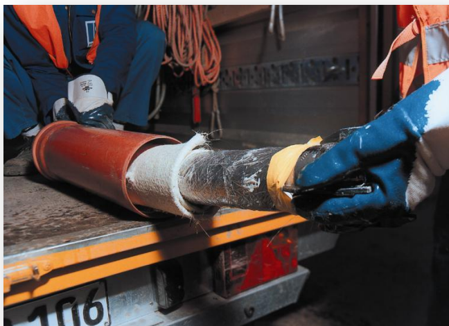
Figura 13 – Introdução do êmbolo com o troço de manga na tubagem a reparar (MANVIA, 2006)
