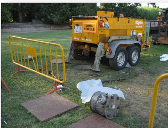
Figura 23 – Guincho de tracção nas imediações de uma caixa de visita (MANVIA, 2007)
