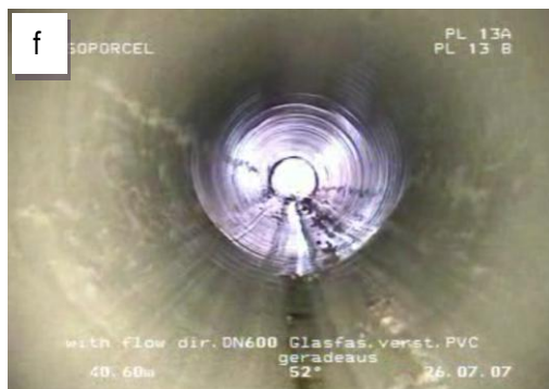
Figura 22 – (a), (b), (c), (d), (e), (f) - Um dia de trabalho na renovação de uma tubagem com manga de fibras de vidro curada por radiação ultravioleta (MANVIA, 2007)
