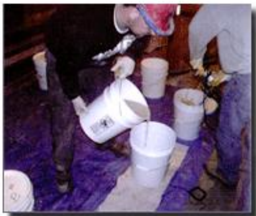
Figura 12 – Preparação « in situ » da resina (MANVIA, 2006)
