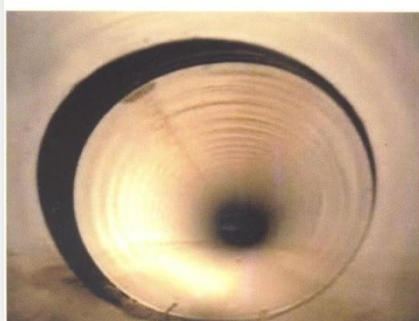
Figura 8 – Exemplos (1), (2), (3), (4) de danos ou defeitos construtivos reparáveis por encamisamento pontual (MANVIA, 2007)
