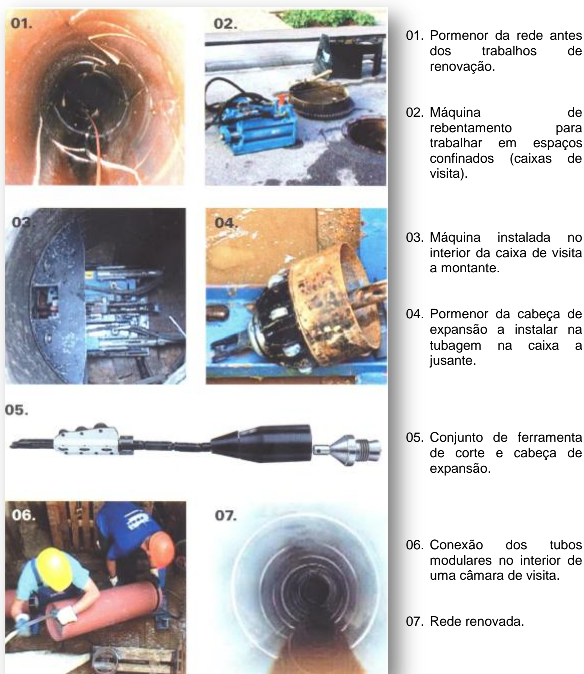
Figura 43 – A renovação de uma rede de drenagem doméstica por entubamento com rebentamento, utilizando tubos modulares (MANVIA, 2007)
