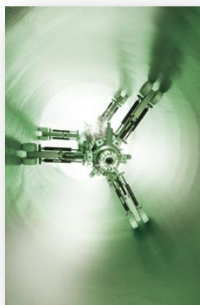
Figura 73 – « UV train » possui acoplada uma câmara de « Closed-Circuit Television » (CCTV)
