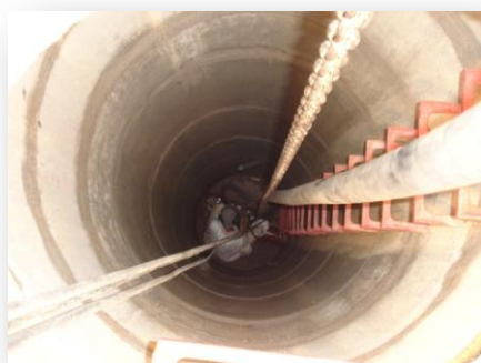
Figura 92 – Guincho montado na caixa montante e abocardamento na caixa jusante durante a execução de um entubamento com rebentamento utilizando tubos modulares - Caso de Estudo 2
