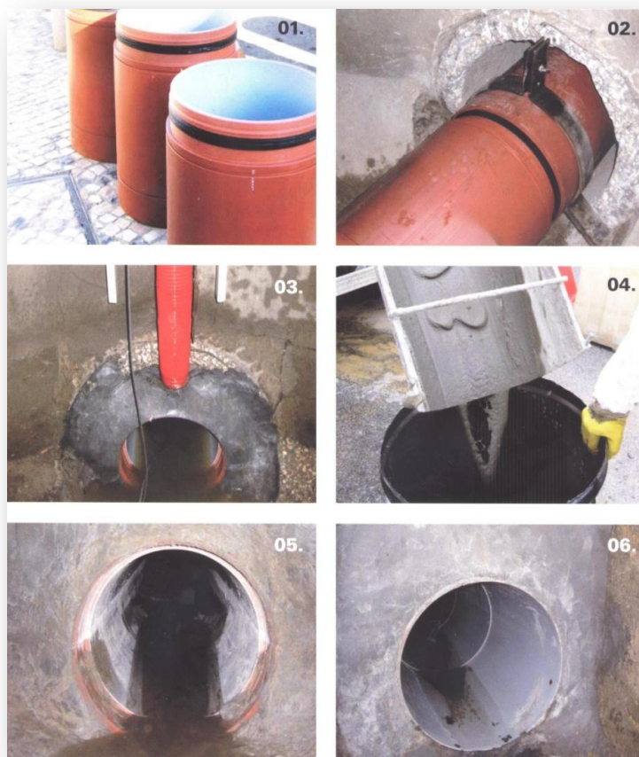
Figura 31 – (01), (02), (03), (04), (05), (06) - A renovação de uma rede de drenagem pluvial com tubos modulares (MANVIA, 2007)
