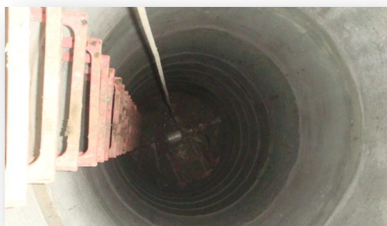
Figura 92 – Guincho montado na caixa montante e abocardamento na caixa jusante durante a execução de um entubamento com rebentamento utilizando tubos modulares - Caso de Estudo 2
