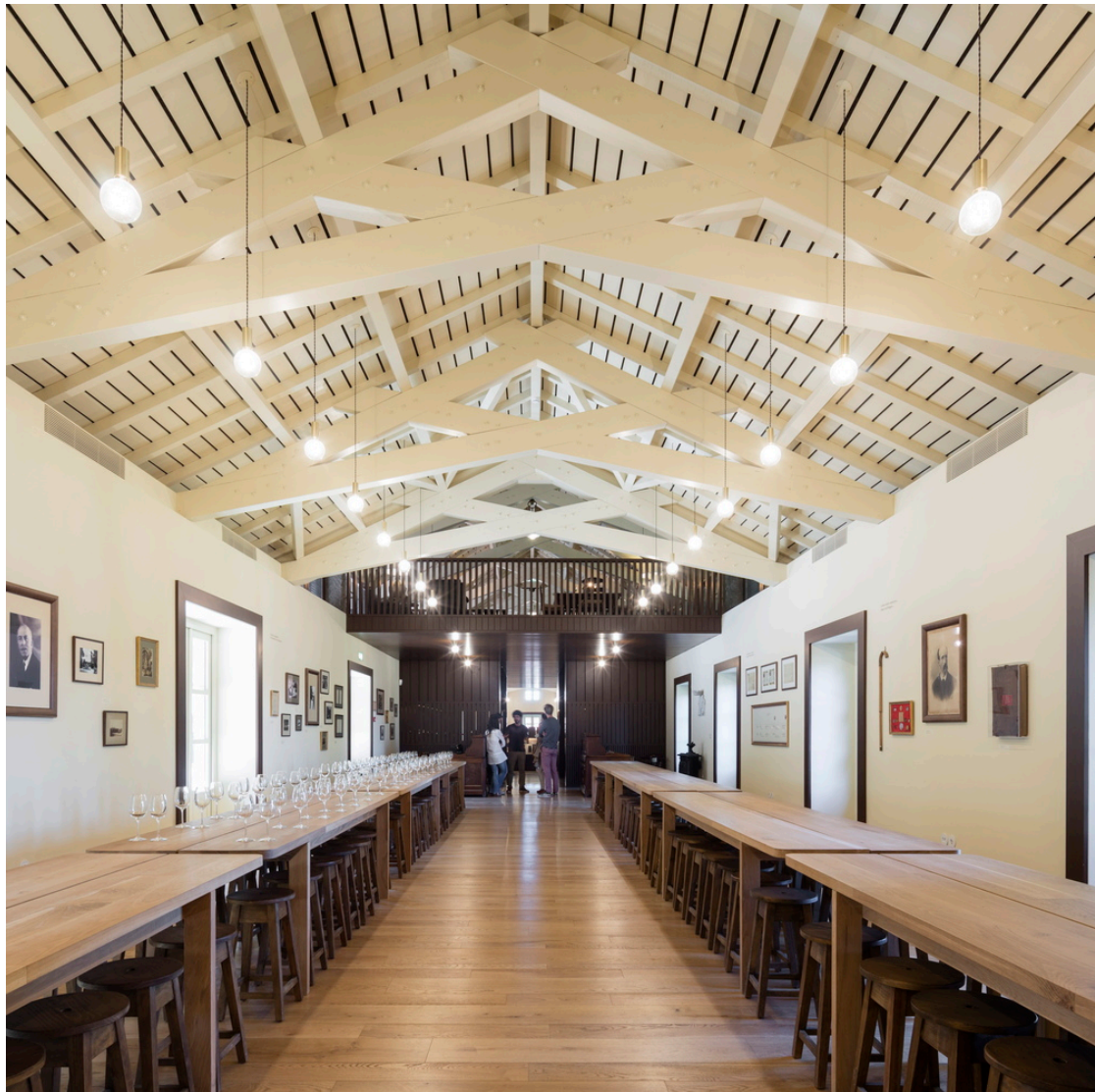
Figura 2. Fotografia interior da sala de provas com visibilidade das asnas Fonte: https://www.archdaily.com.br/br/913029/edificio-para-enoturismo-diogo-aguiar-studio?ad_source=myarchdaily&ad_medium=bookmark-show&ad_content=current-user
