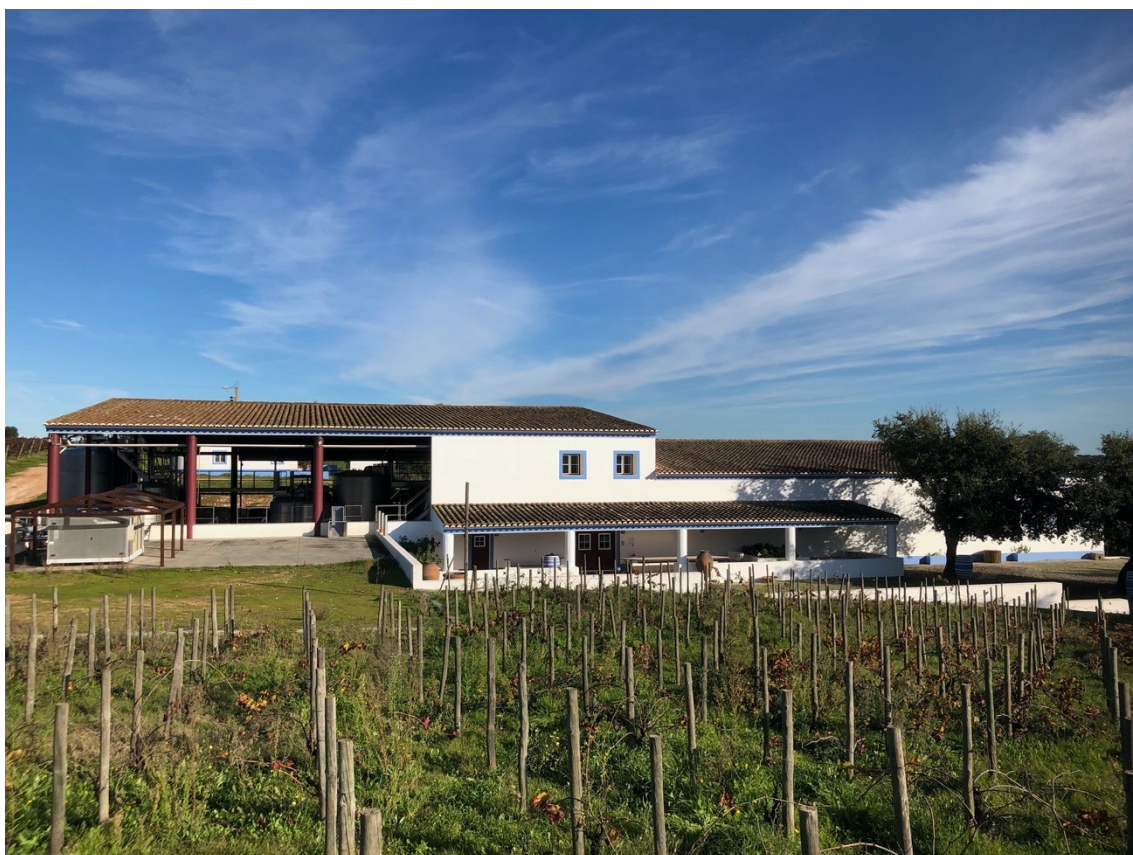
Figura 9. Alçado Oeste Adega da Herdade da Madeira Fonte: (imagem do autor)
