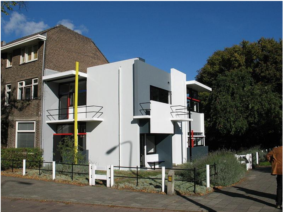
Figura 23: Casa Rietveld Schroder, vista do exterior
