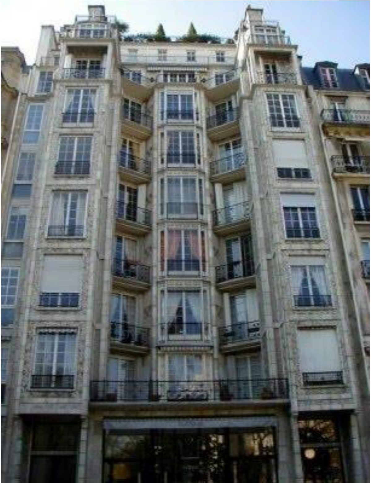
Figura 12:Edifício 25 da rua Franklin 29
