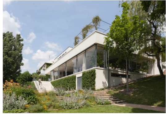
Figura 29: Casa Tugendhat, vista exterior
