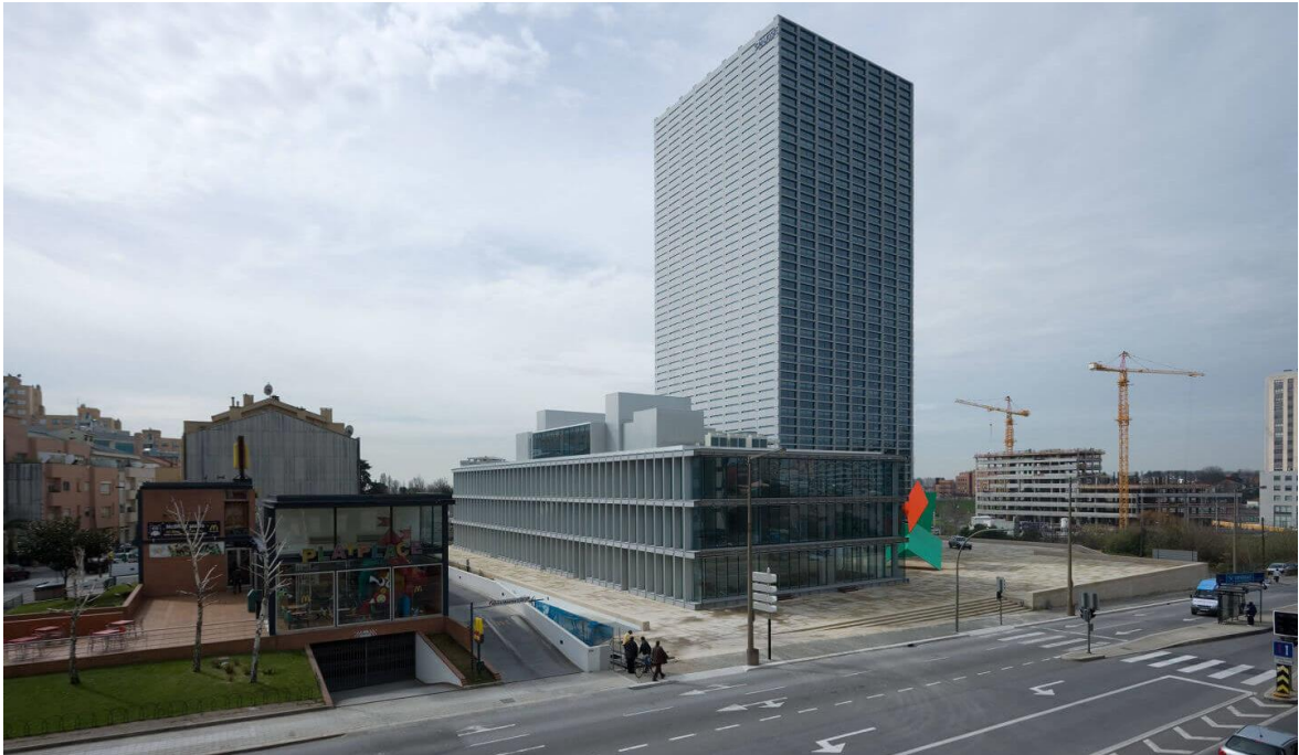
Figura 44: Torre Burgo – Vista exterior
