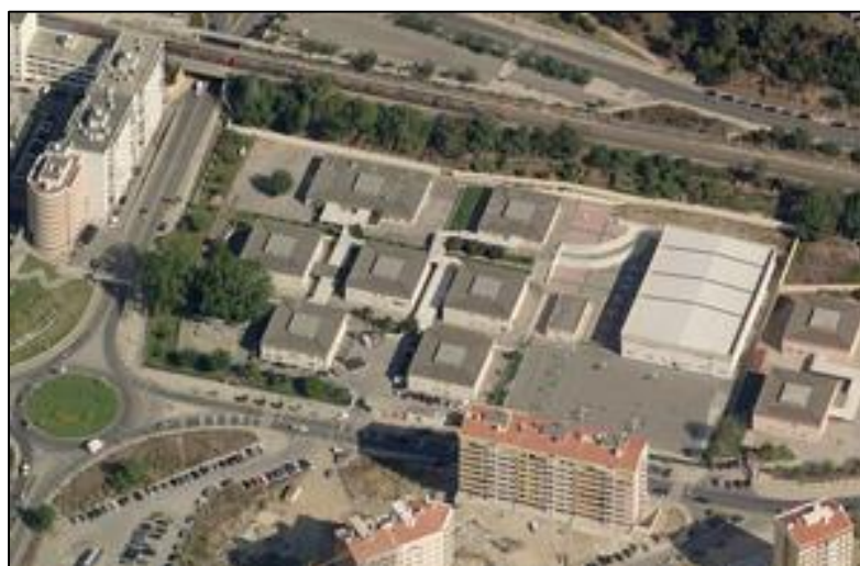
Figura 1: Vista aérea da ESLC e zona envolvente
