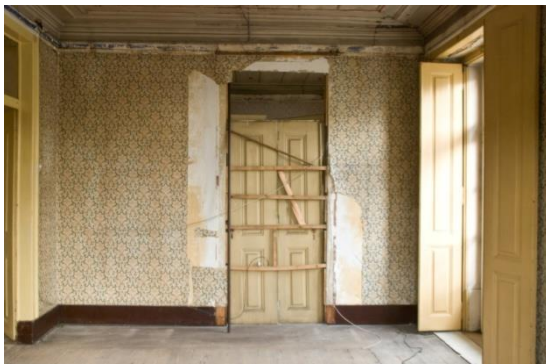
Figura 48: PISO 04 – PORTA estado original.
