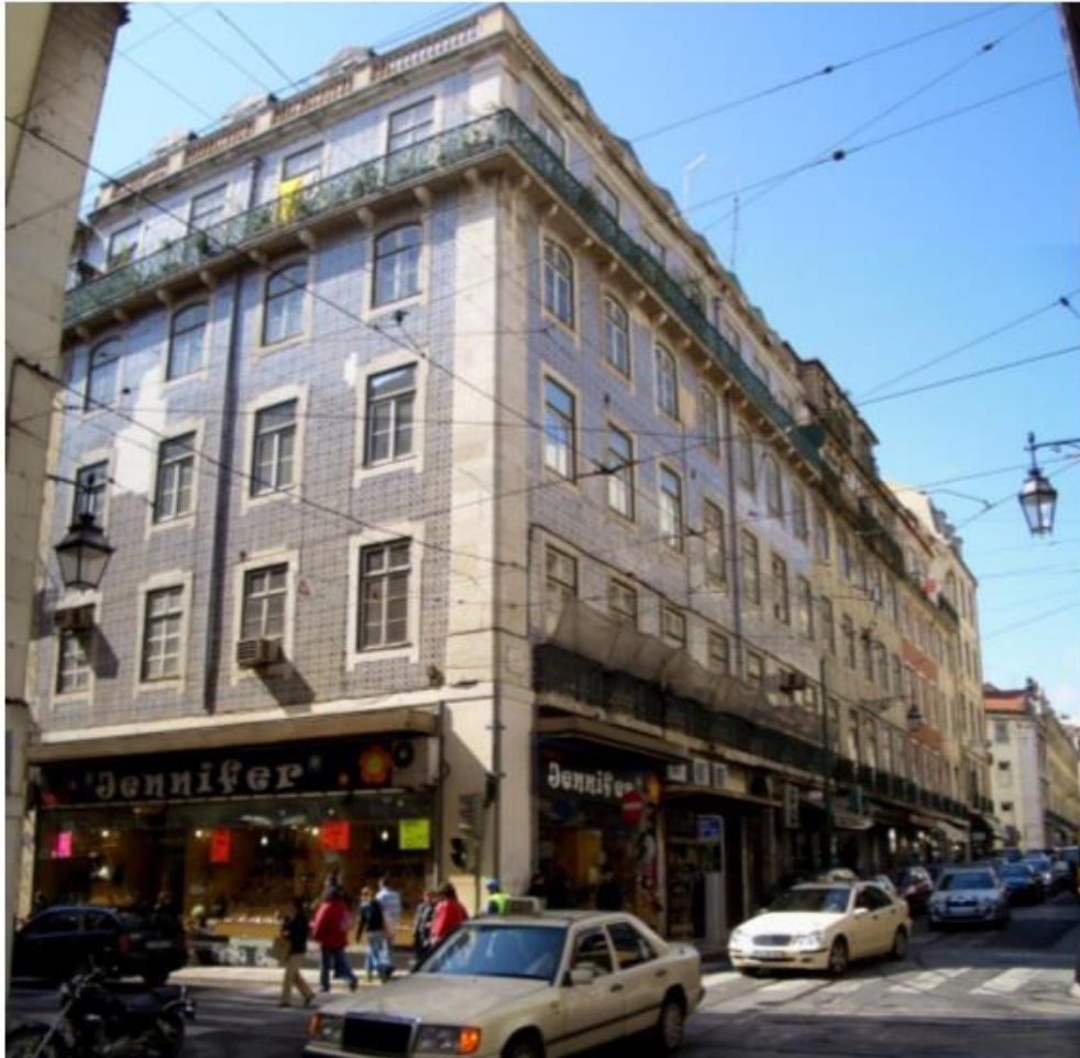
Figura 43: Rua dos Fanqueiros, Lisboa.
