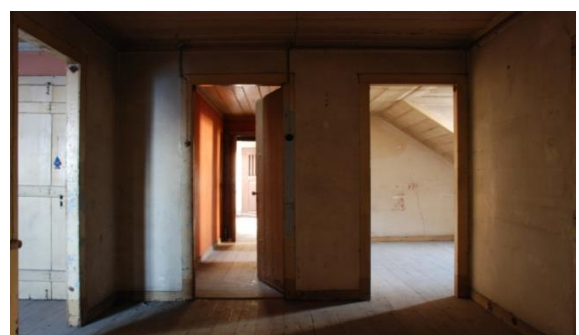
Figura 44: PISO 05 – Estado original.
