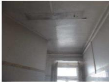
Figura 32: Junto à fachada tardoz.
