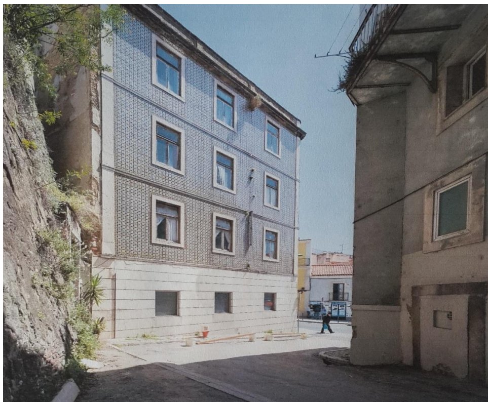
Figura 12: Registo fotográfico do Alçado da Travessa do Livramento, 2019.
