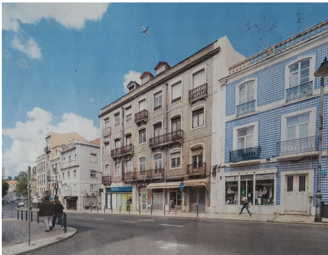
Figura 7: Registo fotográfico do Alçado da Rua Prior do Crato, 2019.
