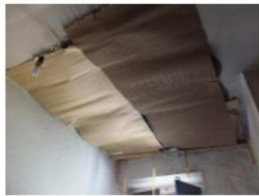
Figura 33: Junto à fachada tardoz.
