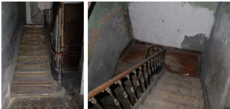
Figura 25: Humidade em parede de alvenaria ao nível do Piso 03.
