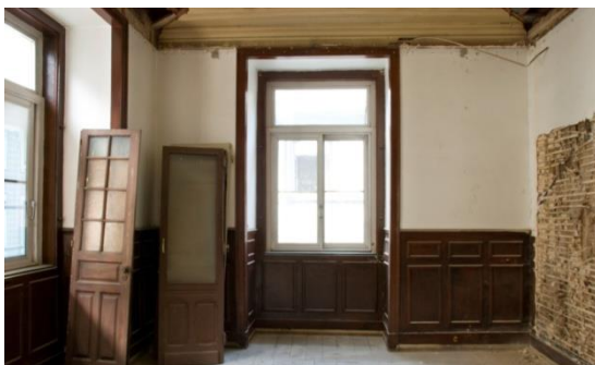
Figura 45: PISO 02 – Estado original.
