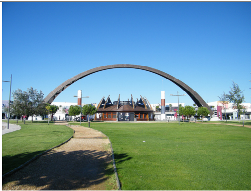
Foto 174. Marca, elemento decorativo Freeport Outlet Shopping, Fonte: Autora, 2009
