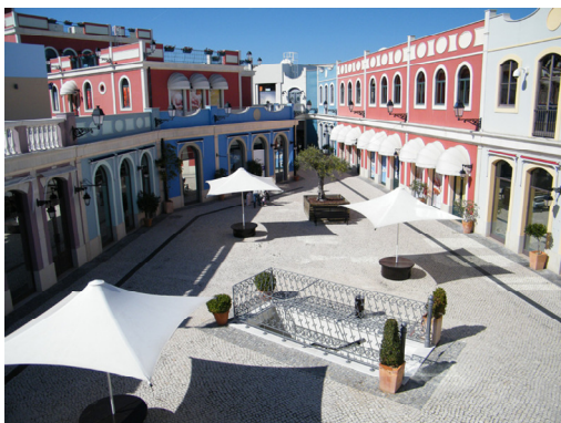
Foto 73. Cor nos edifícios Rua do Claustro, Freeport Outlet Shopping Fonte: Autora, 2009
