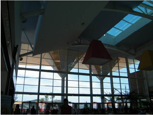
Foto 77. Parede envidraçada; Arena Shopping Fonte: Autora, 2009
