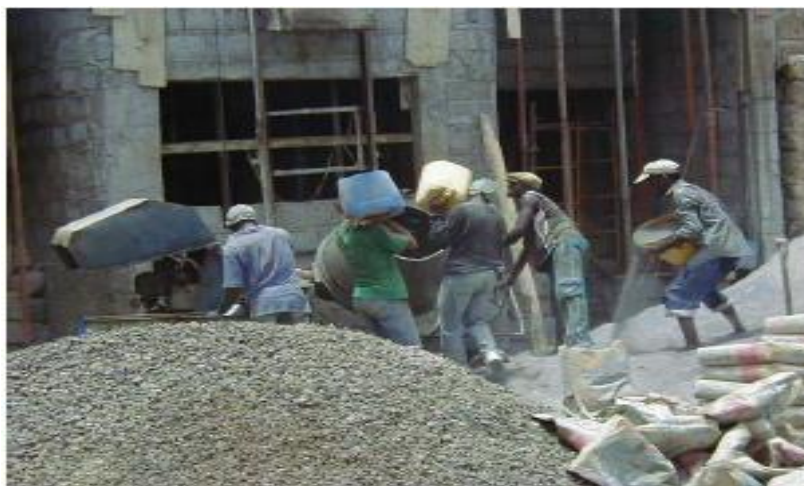
Figura 2.16 – Amassadura do betão para a execução de uma habitação unifamiliar.
