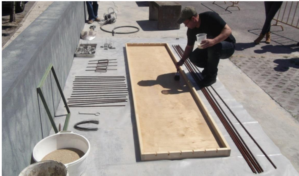
Figura 6.8 – Aplicação de um líquido descofrante sobre o molde de madeira.
