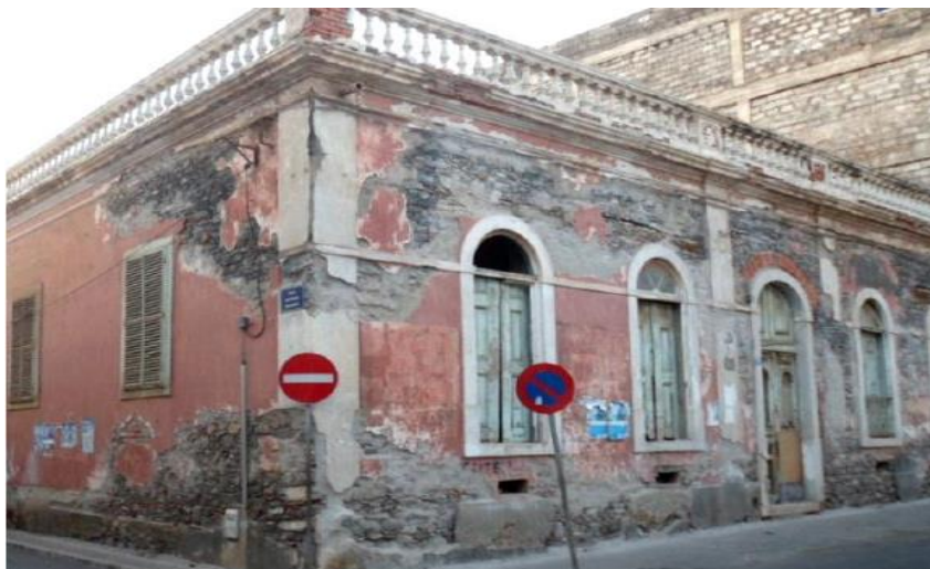
Figura 2.9 – Estado atual de um edifício da época colonial, na cidade da Praia.
