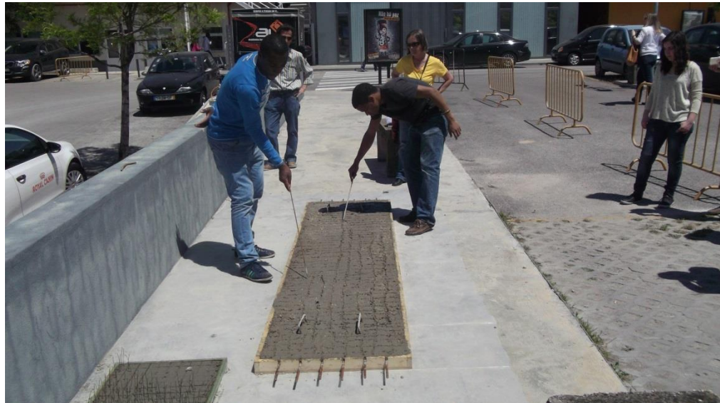
Figura 6.11 – Tratamento da superfície superior da prelaje.
