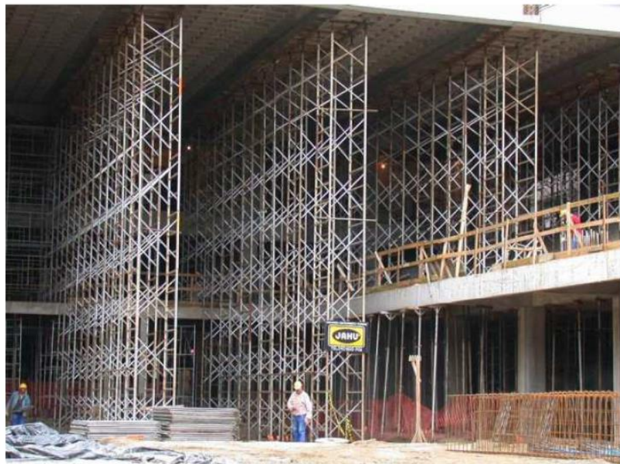
Figura 3.7 - Escoramento metálico (Fevereiro, 2013).
