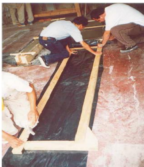
Figura 4.2 – Molde assente em plástico resistente para o fabrico da prelaje.
