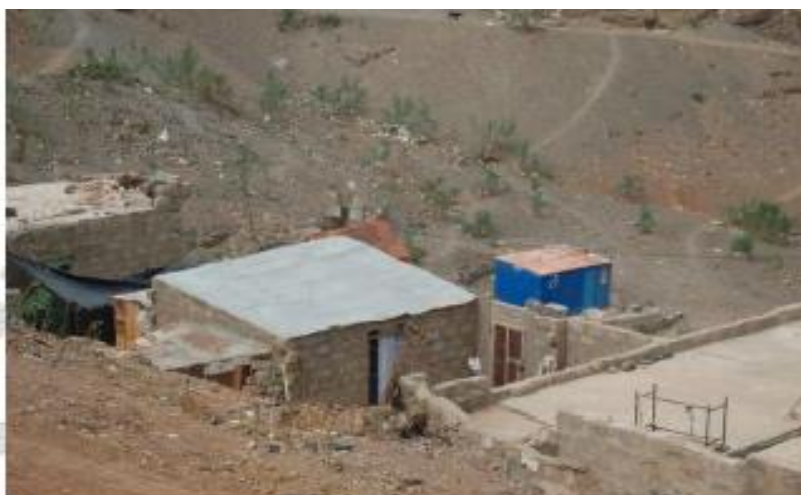
Figura 2.28 – Aspeto de habitações precárias construídas numa encosta e no fundo de uma ribeira.
