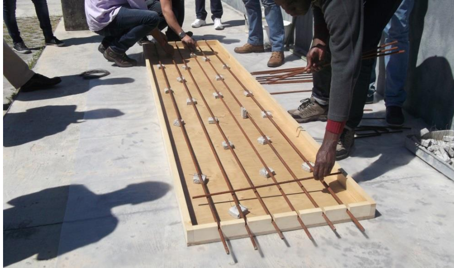
Figura 6.9 – Colocação das armaduras e os respectivos espaçadores.
