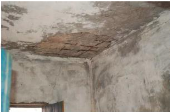
Figura 2.14 – Aspeto de uma cobertura plana com laje de betão armado, onde se observa a armadura à vista por falta de recobrimento.
