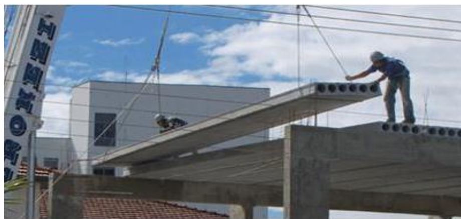
Figura 3.3 – Prancha prefabricada alveolada montada em obra (Albarram, 2008).
