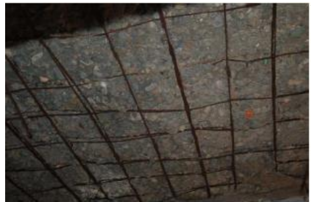
Figura 2.14 – Aspeto de uma cobertura plana com laje de betão armado, onde se observa a armadura à vista por falta de recobrimento.
