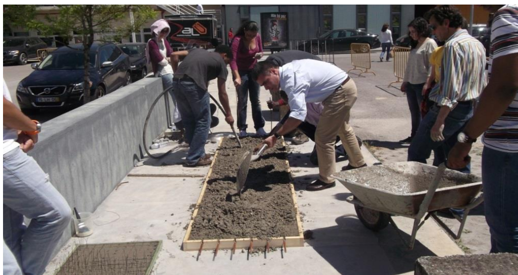
Figura 6.10 – Colocação e espalhamento do betão.
