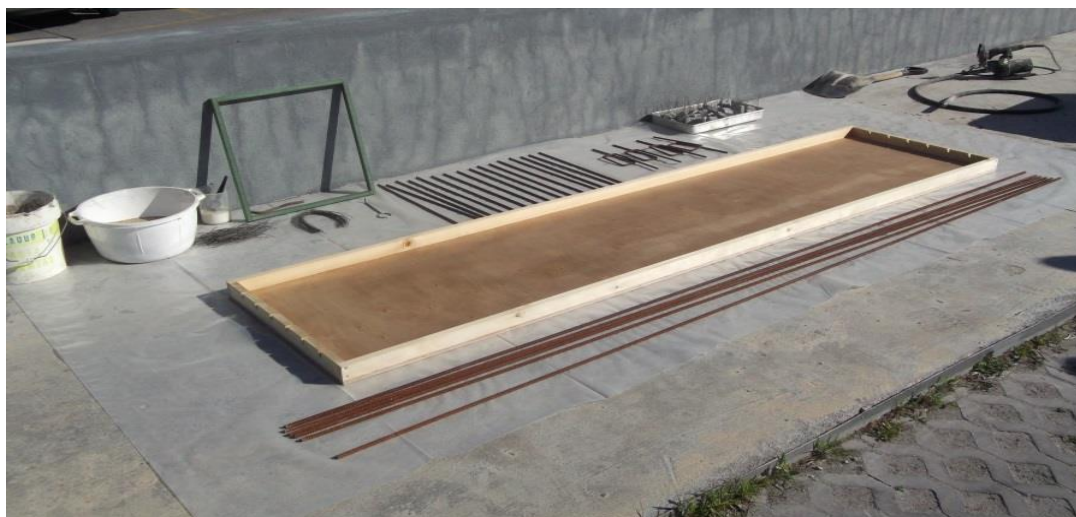
Figura 6.6 – Molde de madeira para o fabrico da prelaje.
