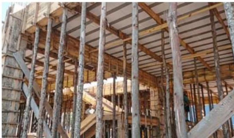
Figura 3.7 – Escoramentos com troncos de madeira, (Fevereiro, 2013).
