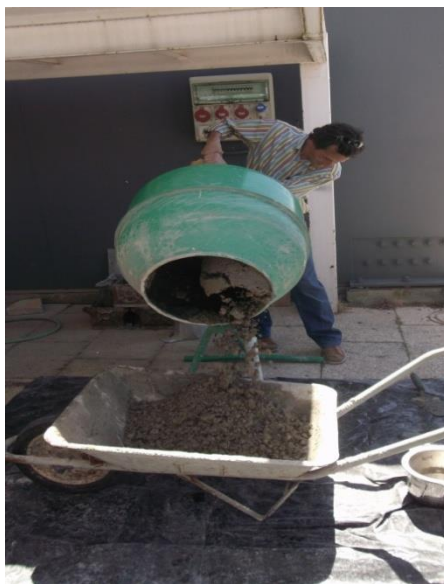
Figura 6.1 – Fabrico do betão para a execução da prelaje.
