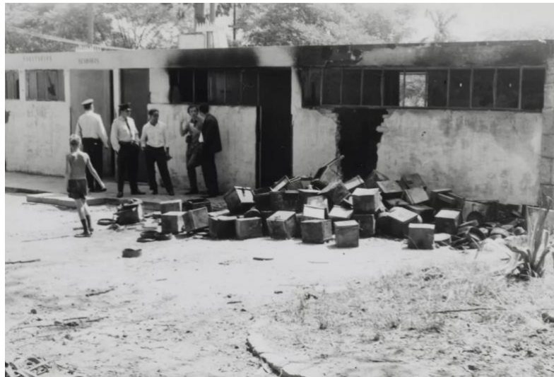
Foto 2 – Incêndio de nitratos em 1969
