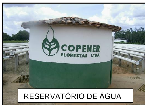
Figura 11. Reservatório de água
