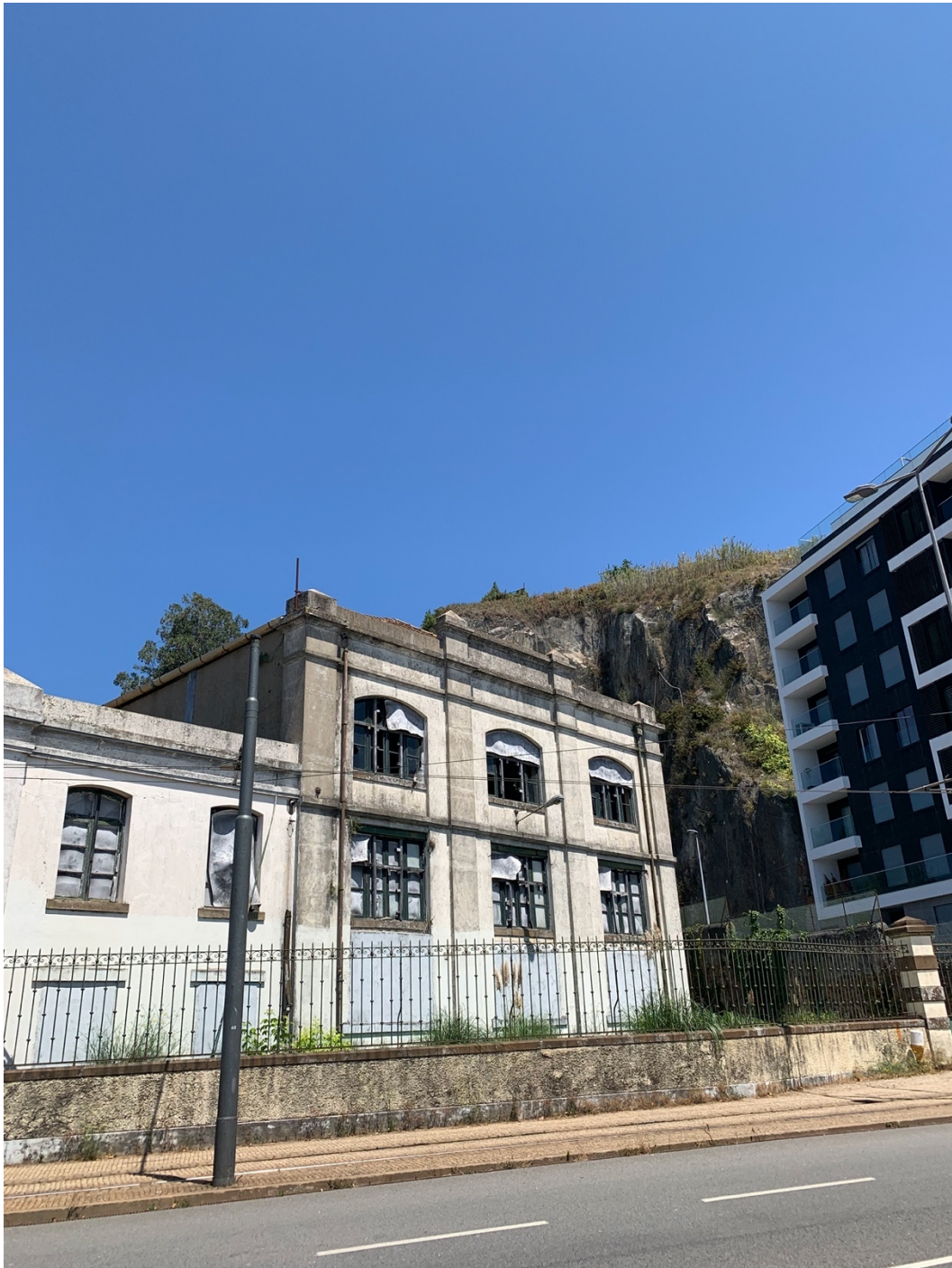
Anexo 16 – Fachada de um dos volumes
