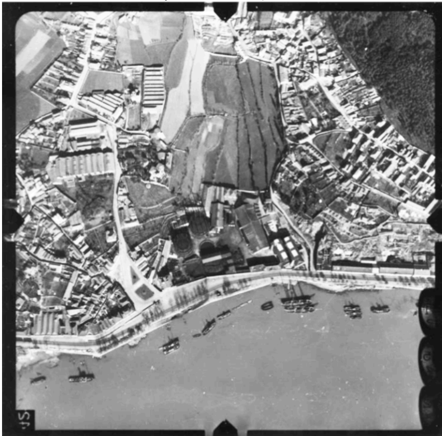
Figura 7- Fotografia aérea da zona do Ouro 58 (fonte: Miranda, Fernando (2016) “Centro contemporâneo de arquitetura – reabilitação da antiga fábrica do Ouro”)
