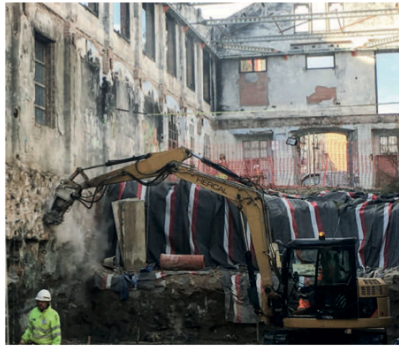
Fressat dels fonaments originals per aconseguir un sol plànel amb el terreny consolidat
