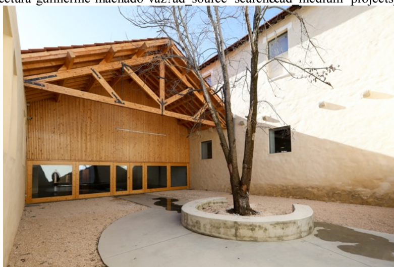
Figura 25- Fotografia interior da Ruína ( fonte: https://www.archdaily.com/884697/real-vinicola-nil-casa-da-arquitectura-guilherme-machado-vaz?ad_source=search&ad_medium=projects_tab )
