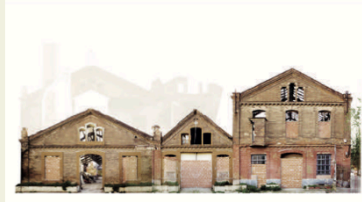
Façana del carrer Pere IV abans de la rehabilitació. A baix, imatge de l'obra finalitzada
