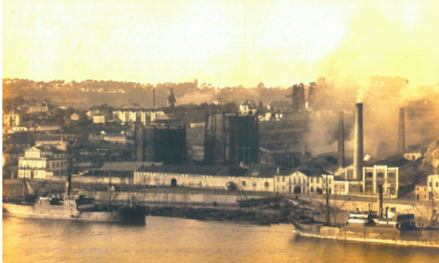
Figura 6- Fotografia da fábrica do ouro, 1907 57 (fonte: Miranda, Fernando (2016) “Centro contemporâneo de arquitetura – reabilitação da antiga fábrica do Ouro”)
