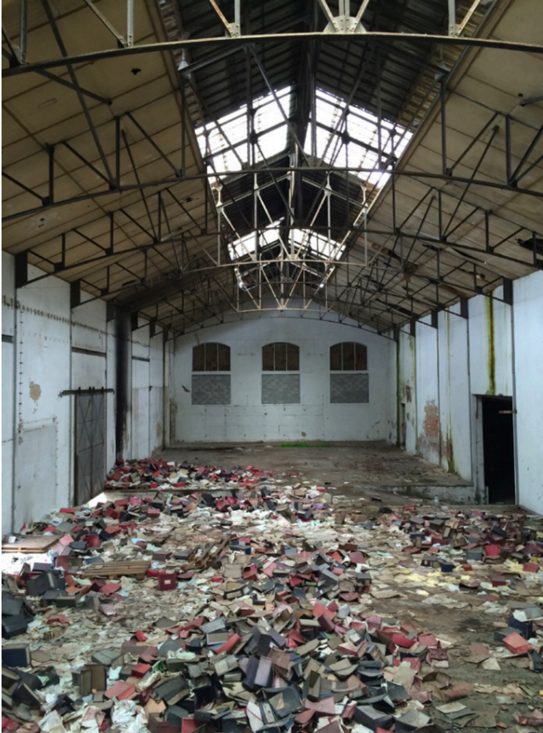
Anexo 12 – Interior de uma das naves (situação atual)
