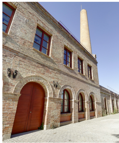
Figura 64- Parede exterior da Fábrica Ca L'alier (fonte: https://bithabitat.barcelona/calalier/ )
