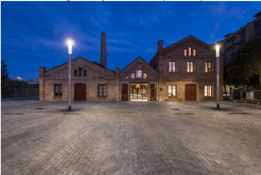
Figura 58- Praça da frente da Fábrica Ca L'alier (fonte: Site oficial dos arquitetos autores do projeto: https://amarq.net/ca/portfolio/antiga-fabrica-ca-lalier/ )
