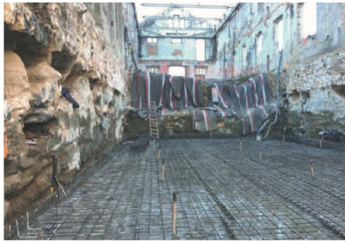
Armadura de la llosa inferior del soterrani.
