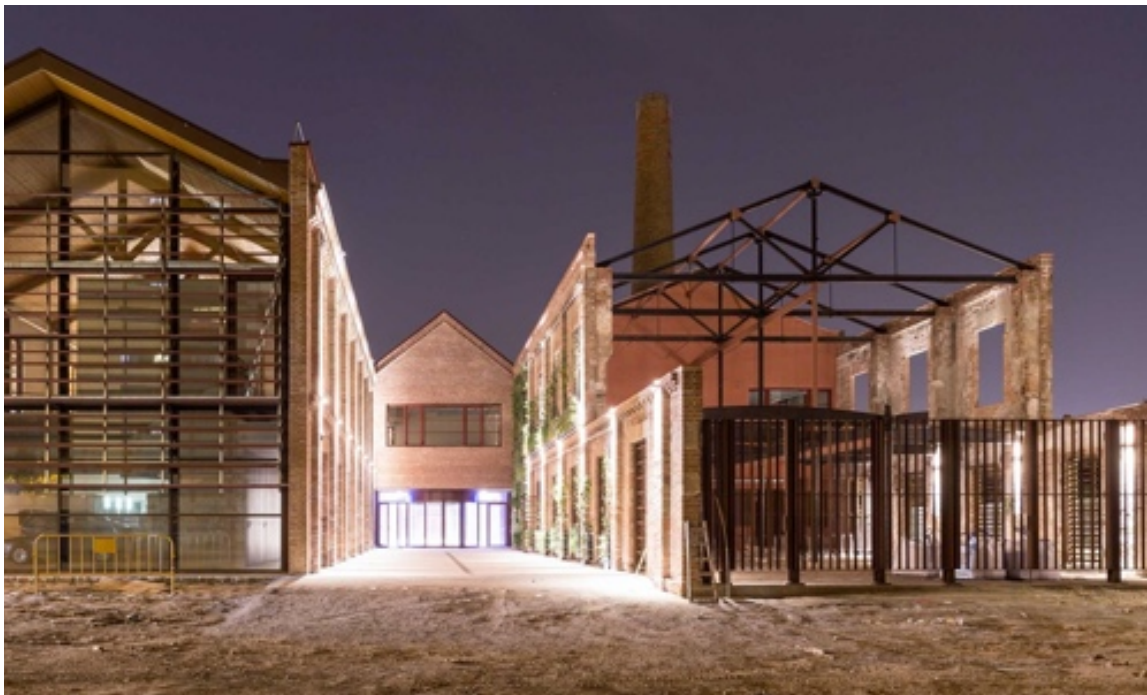
Figura 62- Praça traseira da Fábrica Ca L'alier – em obras (fonte: Site oficial dos arquitetos autores do projeto: https://amarq.net/ca/portfolio/antiga-fabrica-ca-lalier/ )
