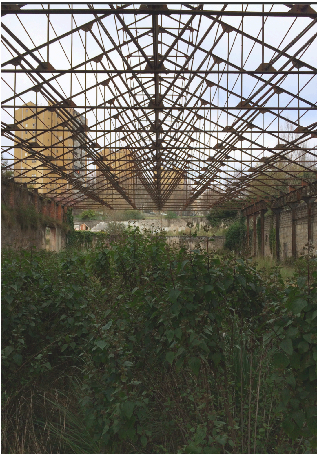
Anexo 8 – Interior da ruína
