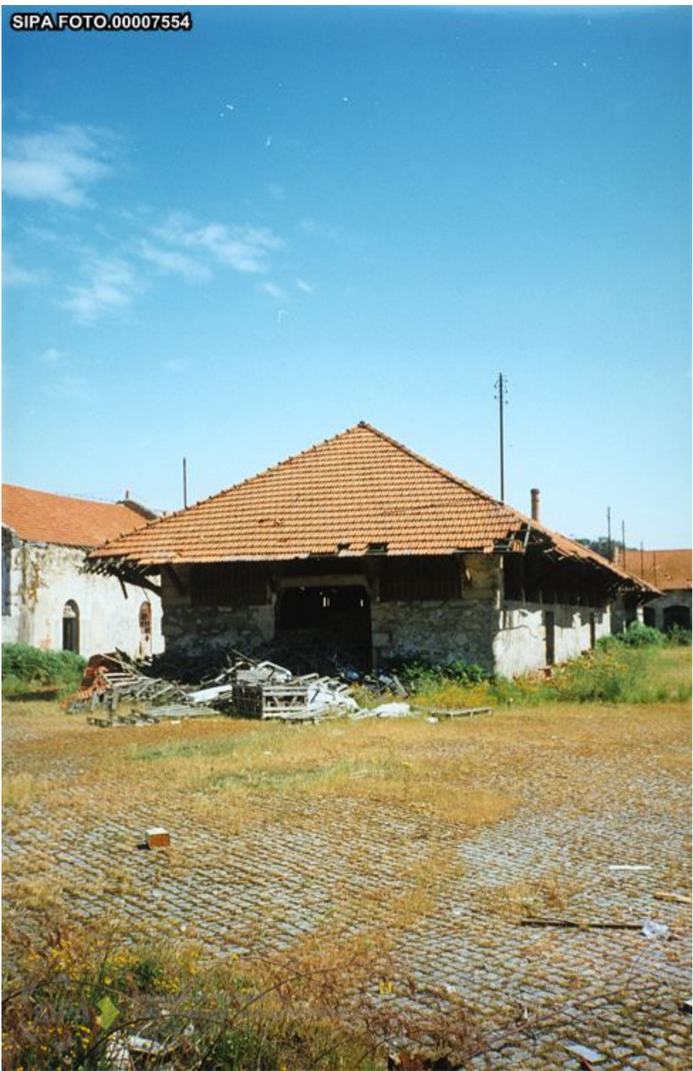
Anexo 34 – Interior do quartirão
