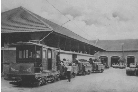
Figura 16- Interior do quartirão do Edifício da Real Vinícola (fonte: (Lopes, 2019)) 69
