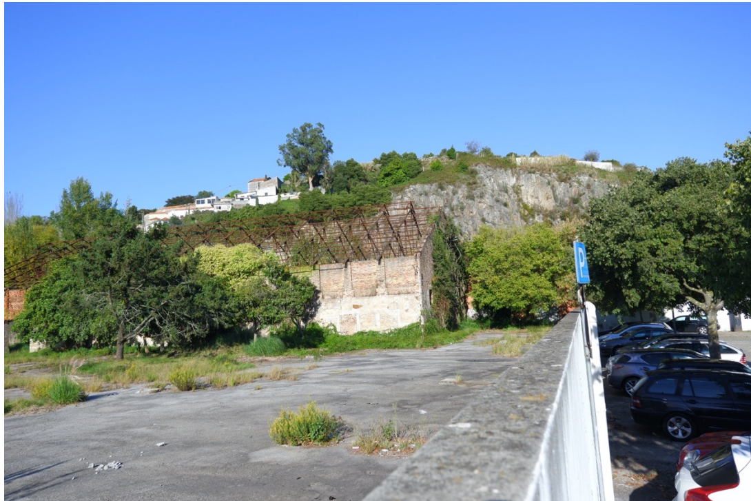
Anexo 15 – Vista da ruína (exterior)
