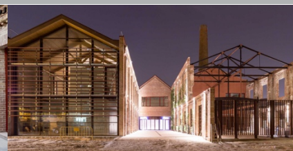
Figura 14- Fotografia do exterior (traseiras) (fonte: https://amarq.net/es/portfolio/antigua-fabrica-ca-lalier/ )
