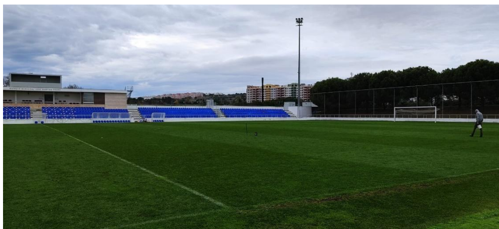
Figura 1: Estádio Municipal José Martins Vieira, Campo nº1.
