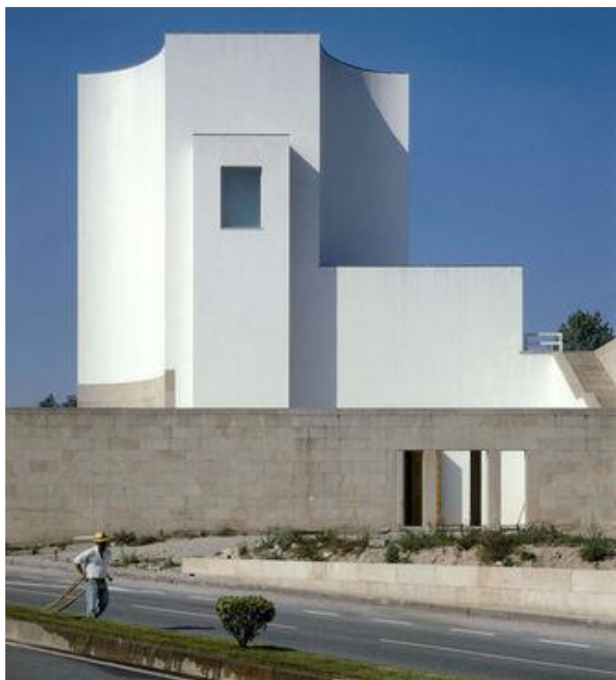
Figura 56 Foto do Alçado Norte e Capelas Mortuárias
