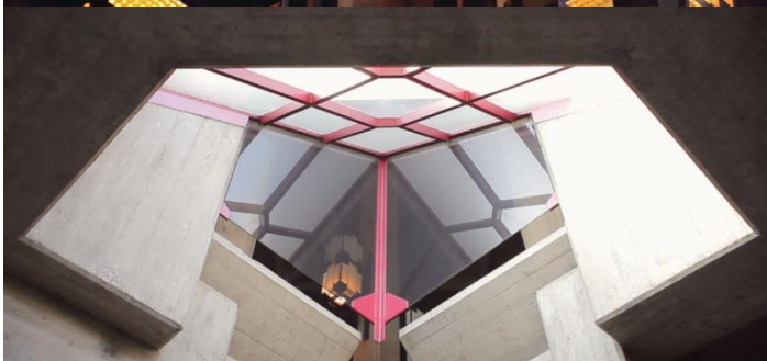
Figura 43 Foto do Lanternim no Local Original do Batistério
