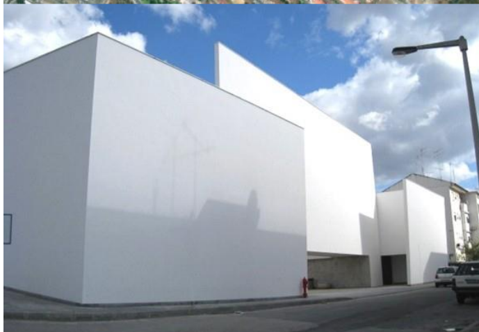
Figura 77 Foto Relação do Edifício com a Rua
