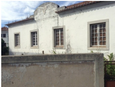
Figura 119 - Habitação dos funcionários do Caminho-de-ferro. (Autor,2013).
