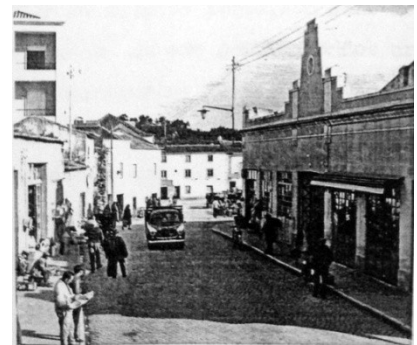
Figura 153 - Antigo Mercado Municipal, construído em 1933. (BMTV,2013)
