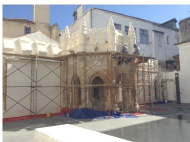
Figura 22 - Largo Infante D. Henrique, obras de conservação do Chafariz dos Canos. (Autor, 2013)
