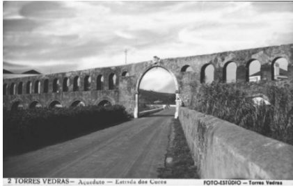
Figura 89- Aqueduto, séc. XX. (BMTV,2012)
