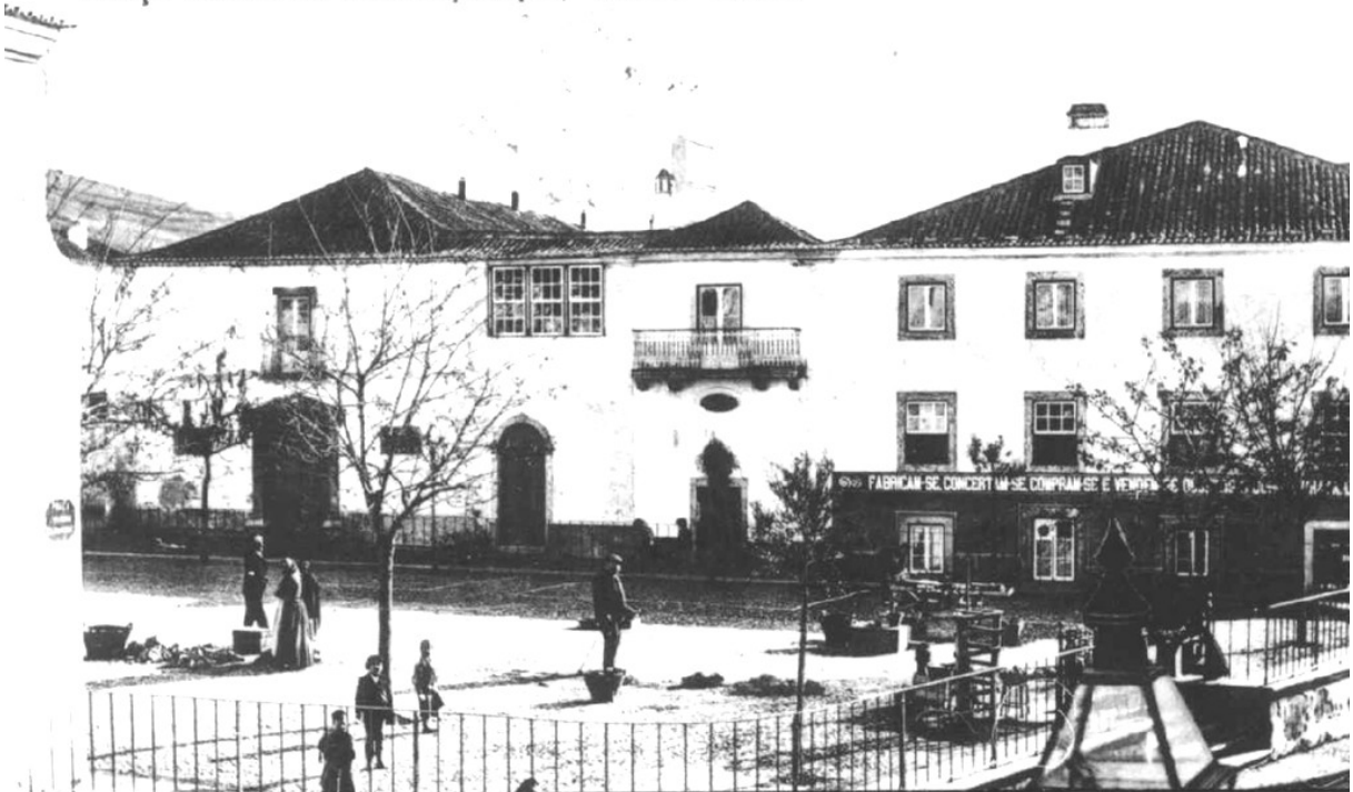
Antiga Praça Mouzinho de Albuquerque e à direita, o edifício onde existe, actualmente, o café A Brasileira . (BMTV, 2013)
