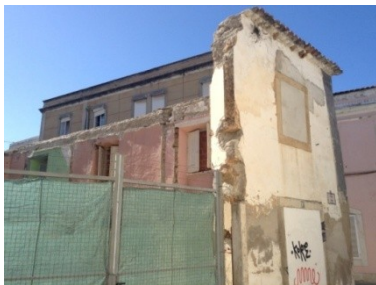
Figura 28 - Reconstrução de Edifício. Travessa de S. Pedro. (Autor,2013)
