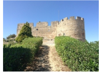
Figura 44- Actual fachada sul do Castelo. (Autor, 2013)
