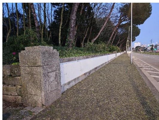
Figura 19: Muro de Contenção e Talude na Av. da Boavista. Fonte: Acervo Pessoal da Autora.
