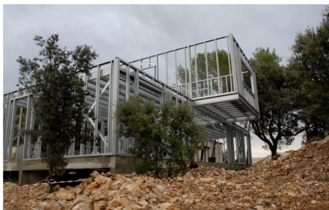
Figura 25: Estrutura da casa em LSF
