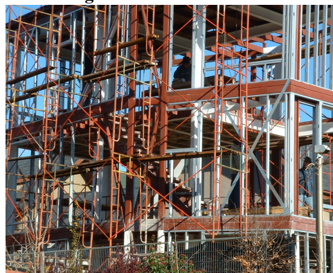
Figura 40: estrutura da casa com LSF
