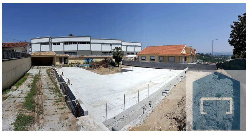
Figura 4: Fundação moradia em Lousada
