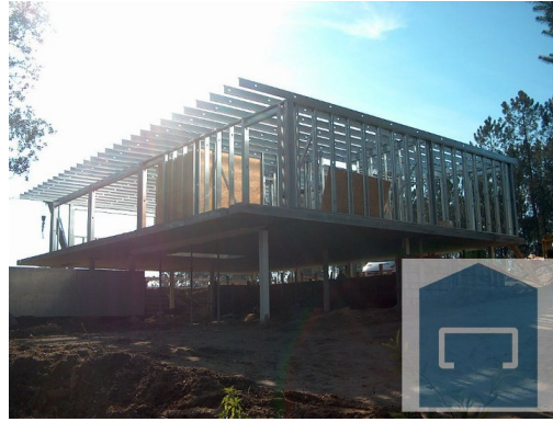
Figura 5: Estrutura com técnicas convencionais moradia em Lago Amareos
