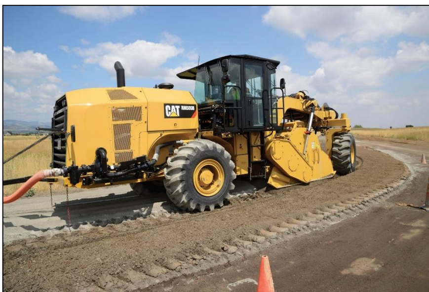
Figura 2.4 – Estabilização de solo através da mistura com cimento (CAT, 2023)
