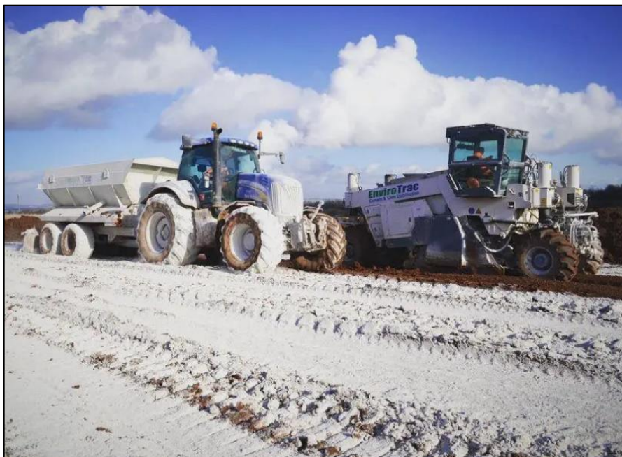
Figura 2.5 – Estabilização de solo através de cal (Obinna, 2022)
